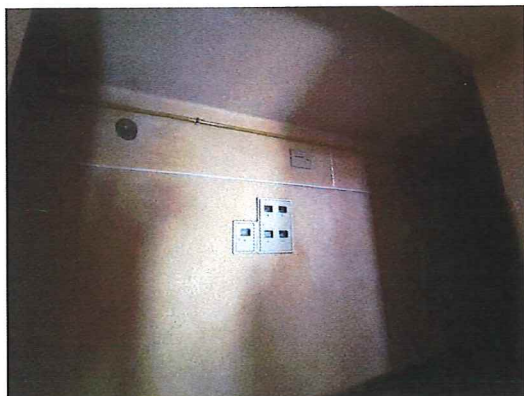
Fot. 21. Widok klatki schodowej – kondygnacja powtarzalna.
