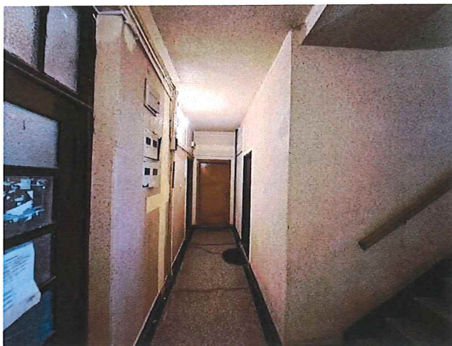
Fot. 11. Widok klatki schodowej na poziomie parteru.
