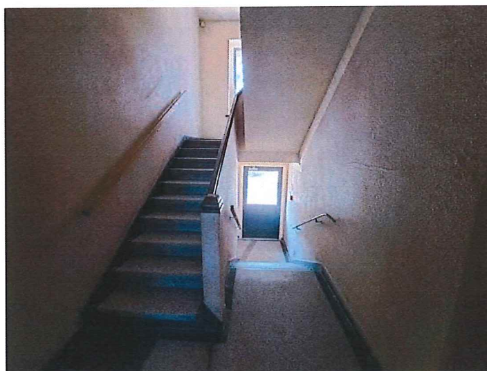
Fot. 10. Widok klatki schodowej na poziomie parteru.
