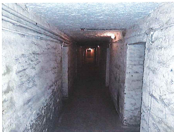
Fot. 16. Widok komunikacji w piwnicy.
