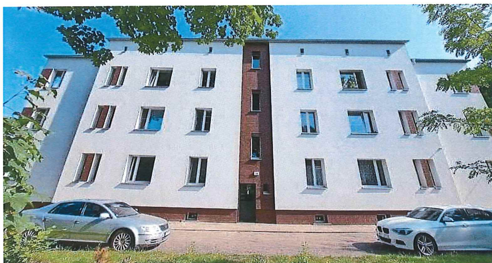
Fot. 7. Widok elewacji tylnej.
