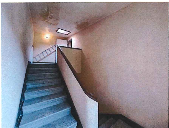
Fot. 24. Widok klatki schodowej – ostatnia kondygnacja.
