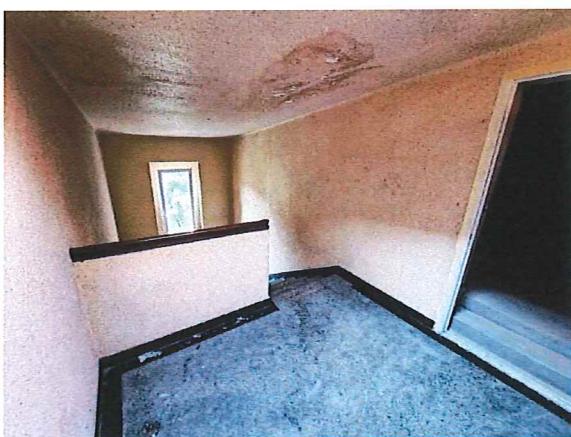
Fot. 26. Widok klatki schodowej – ostatnia kondygnacja.
