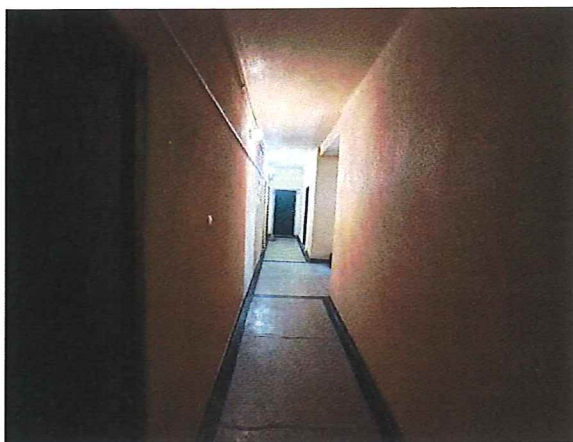
Fot. 22. Widok klatki schodowej – kondygnacja powtarzalna.
