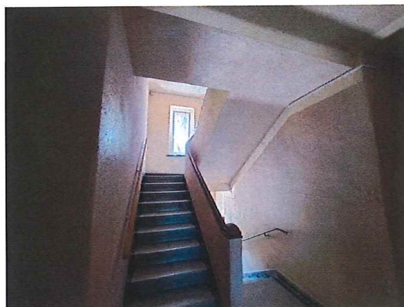
Fot. 19. Widok klatki schodowej – kondygnacja powtarzalna.
