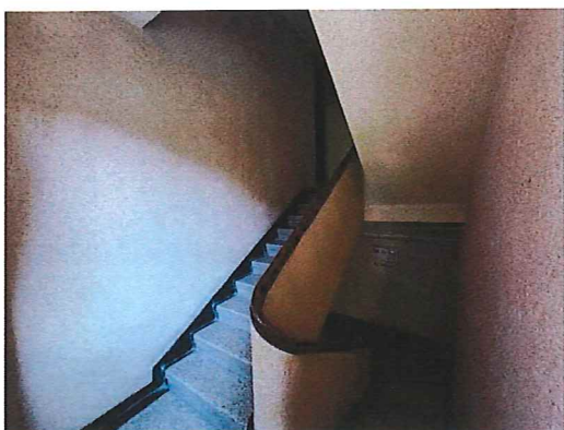
Fot. 20. Widok klatki schodowej – kondygnacja powtarzalna.
