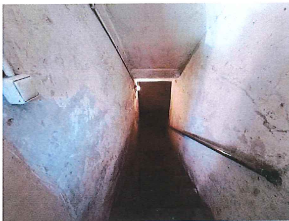
Fot. 14. Widok klatki schodowej – zejście do piwnicy.
