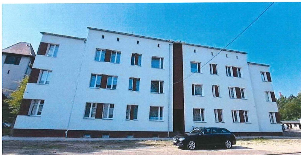
Fot. 6. Widok elewacji frontowej.
