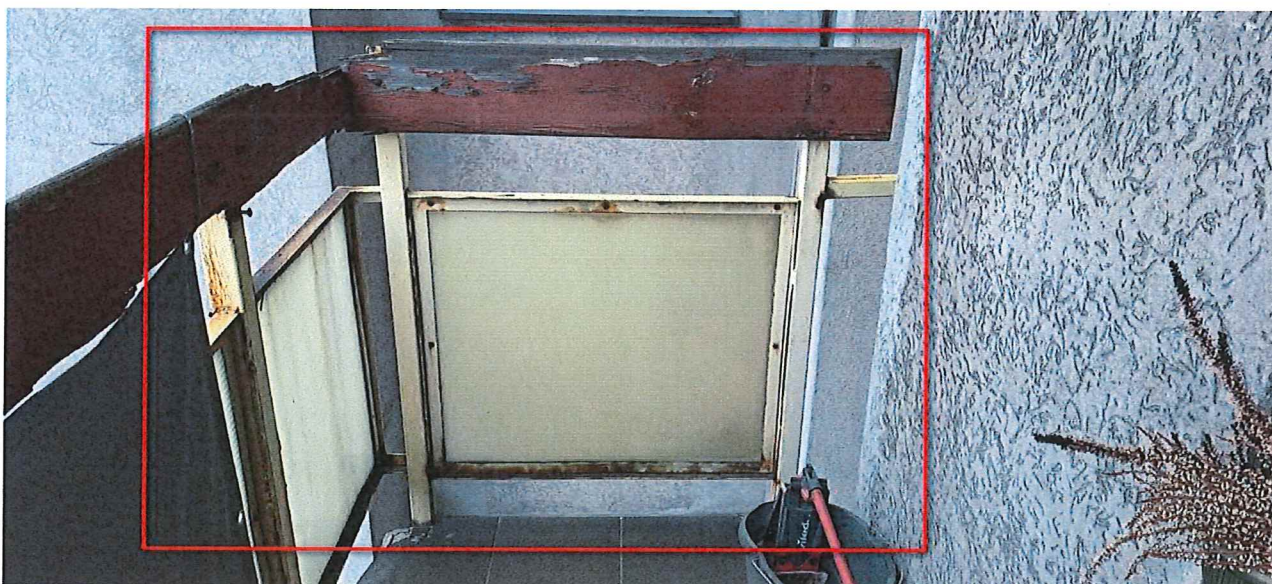
Fot. 7. Widok przykładowego balkonu przeznaczonego do remontu.
