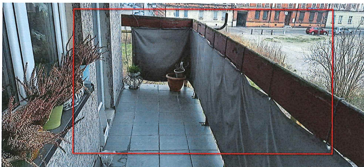
Fot. 8. Widok przykładowego balkonu przeznaczonego do remontu.
