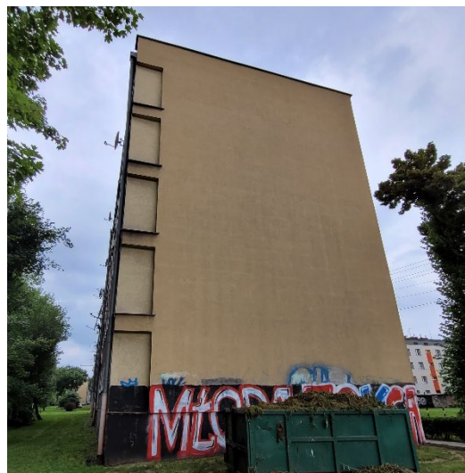
Fot. 6. Elewacja wschodnia
