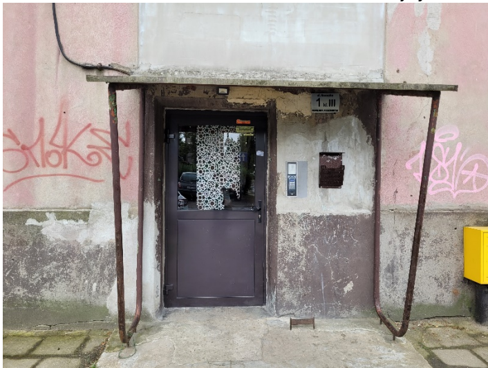
Fot. 2. Wejście do klatki
