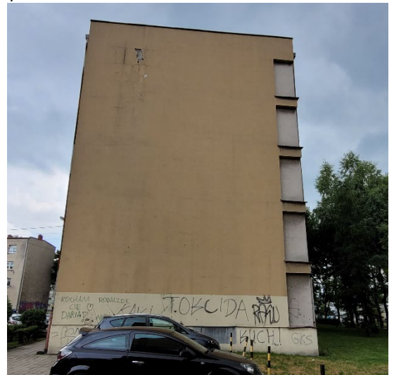
Fot. 4. Elewacja zachodnia
