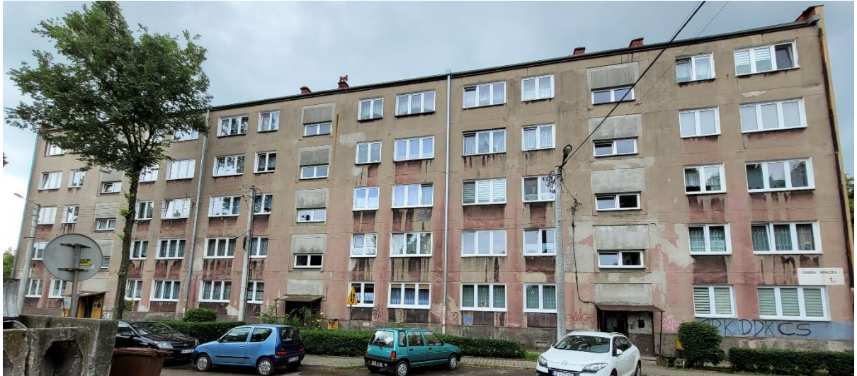
Fot. 1. Elewacja frontowa – północna
