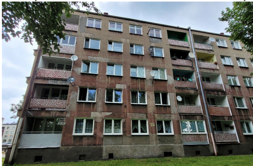
Fot. 4. Fragment elewacji południowej
