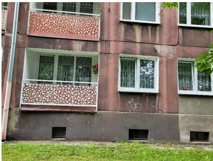
Fot. 5. Fragment elewacji południowej
