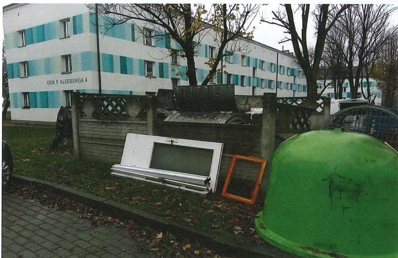
Fot. 2-3 Widok obecnego placyka gospodarczego przynależnego do budynków
