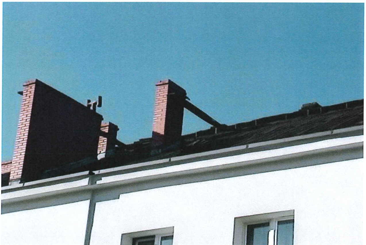
Widok ogólny połaci dachu oraz istniejących drewnianych ław kominiarskich.
