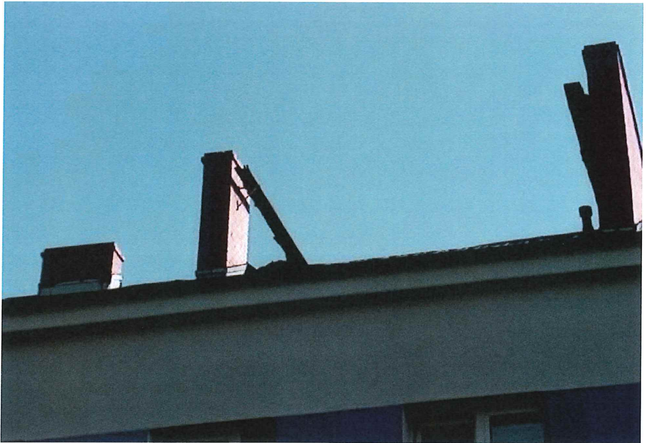
Widok ogólny połaci dachu oraz istniejących drewnianych ław kominiarskich.
