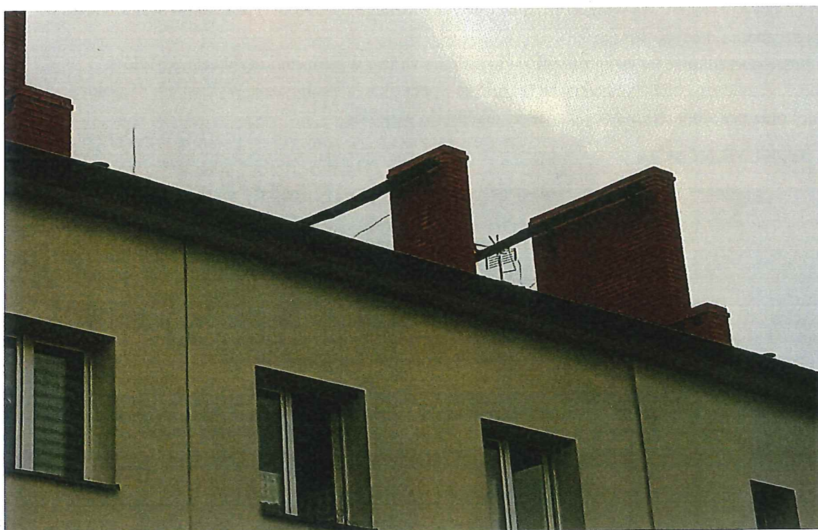
2,2a / Widok ogólny budynku, połaci dachu oraz istniejących drewnianych ław kominiarskich.
