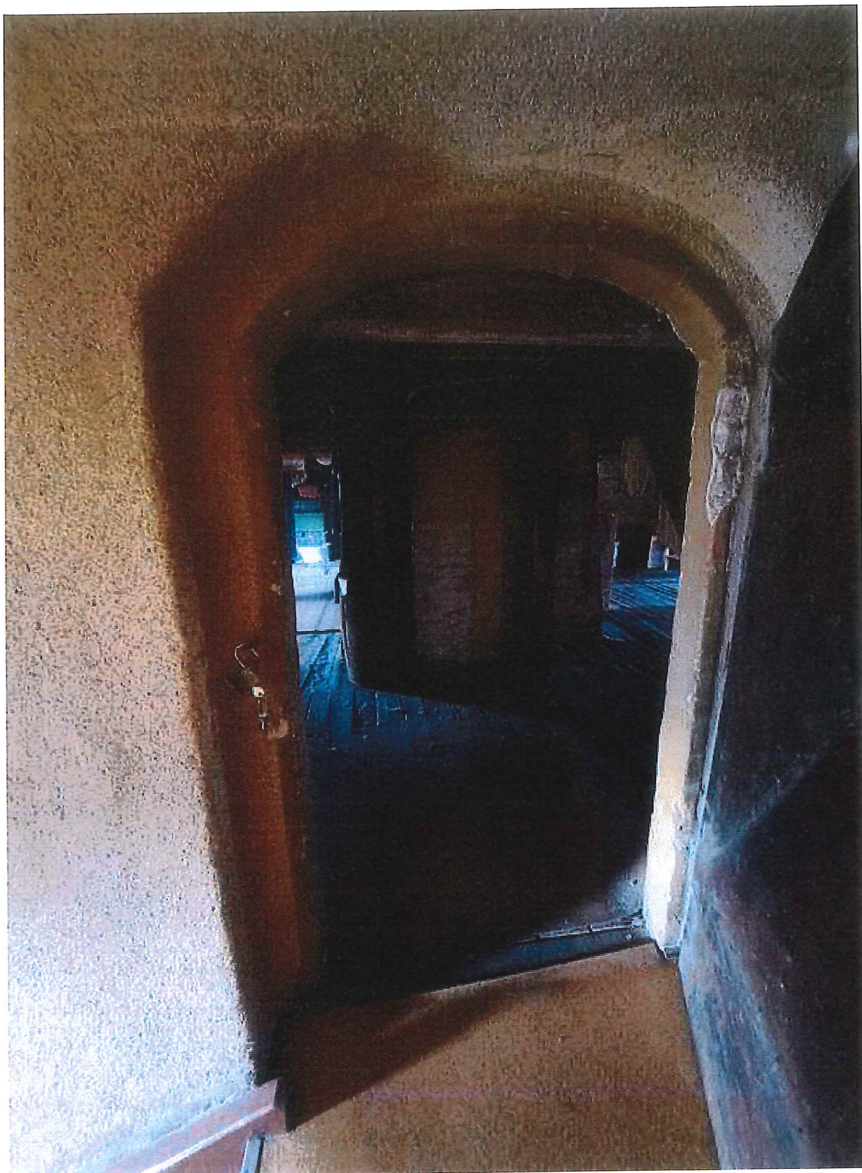
Fot. 8. Wejście na strych nieużytkowy.
