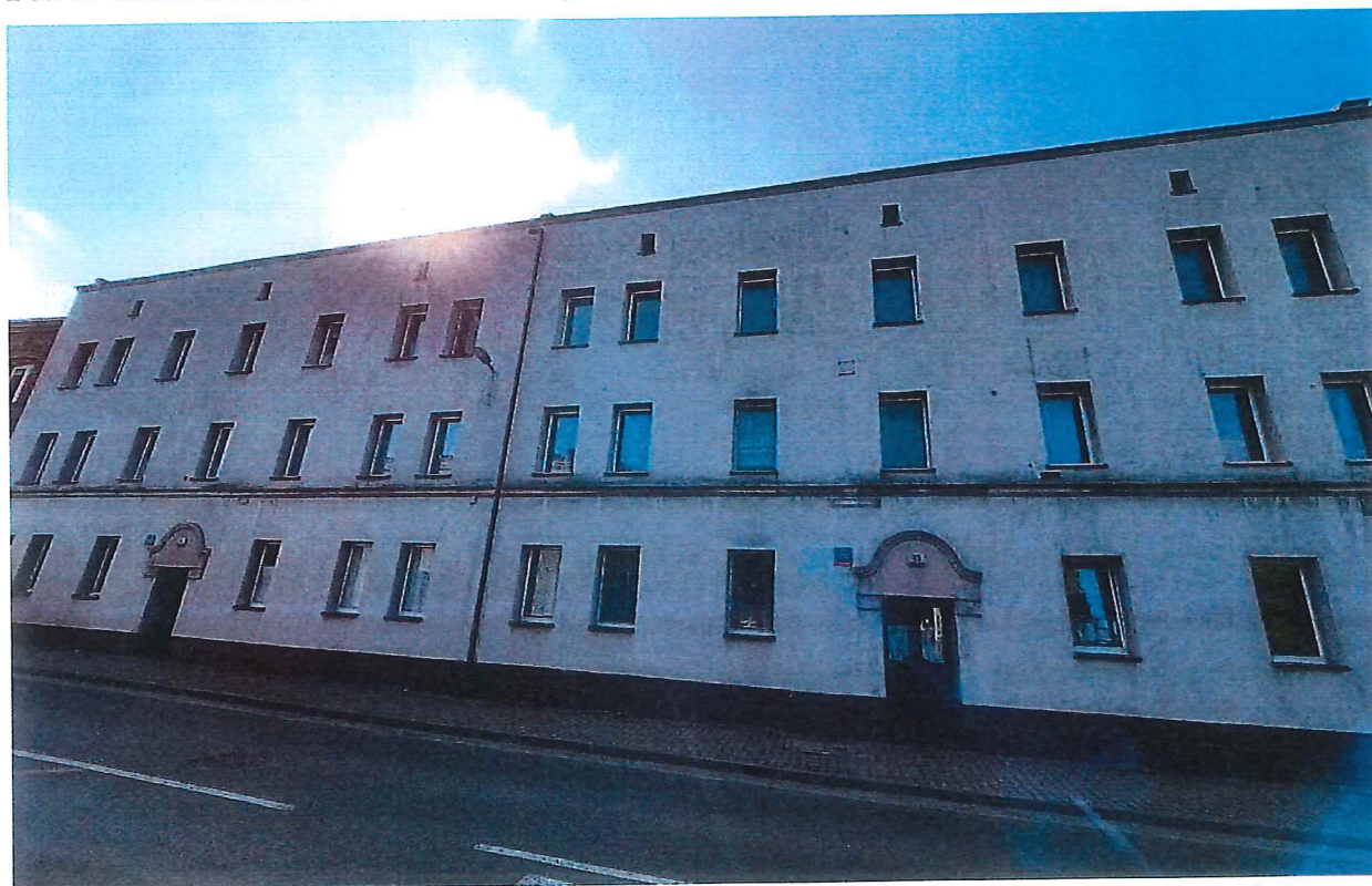
Fot. 2. Widok budynków przy ul. Karola Miarki 15, 16 od frontu.
