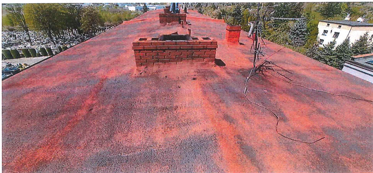
Fot. 7. Widok ogólny połaci dachowej w drugim kierunku.
