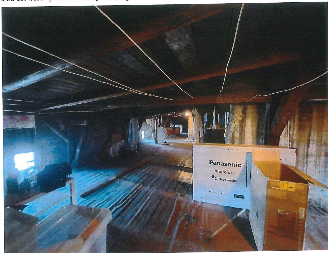
Fot. 17. Widok poddasza nieużytkowanego – więźba dachowa do wzmocnienia lub wykonania na nowo.
