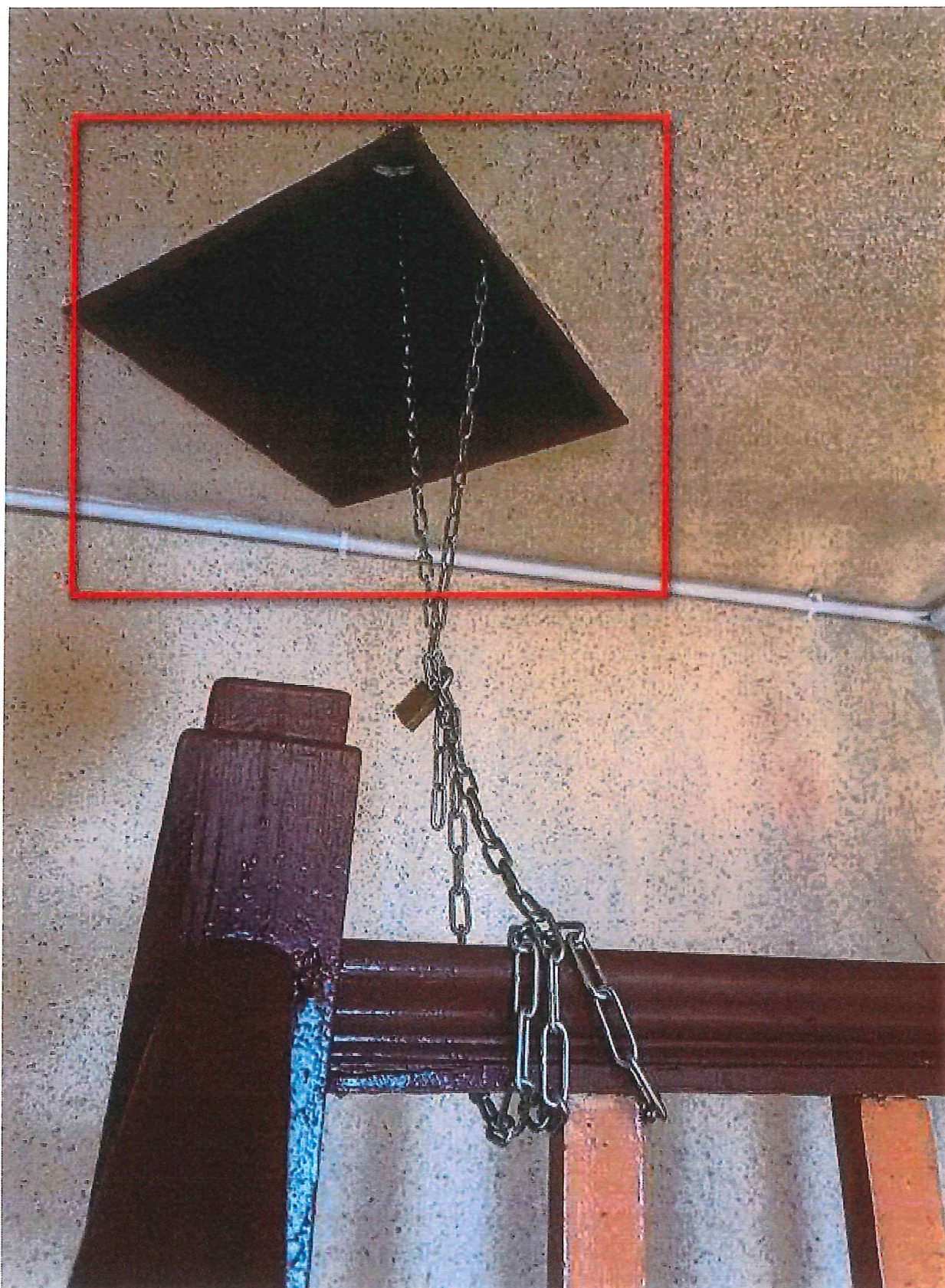
Fot. 9. Wyłaz dachowy do wymiany – na nowy, systemowy.
