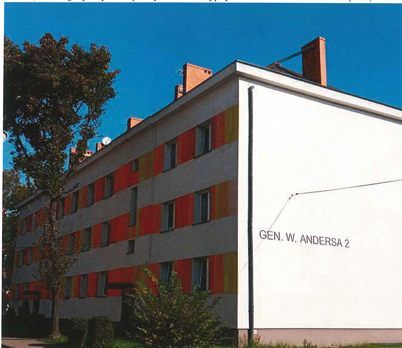
Załącznik nr 3; Widok ogólny budynku Wspólnoty Mieszkaniowej przy ul. Gen. Andersa 2 w Piekarach Śląskich;
