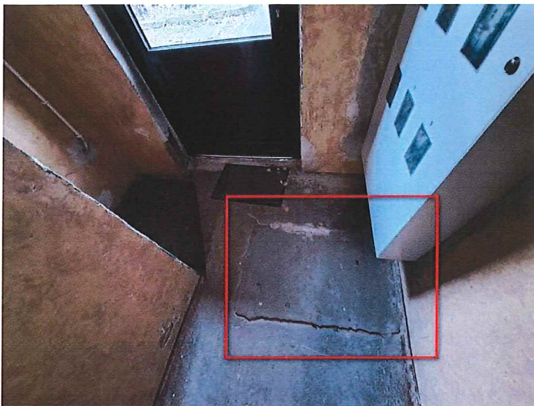
Fot. 36. Widok ogólny klatki nr II – przestrzeń do wykucia pod nową wycieraczkę.
