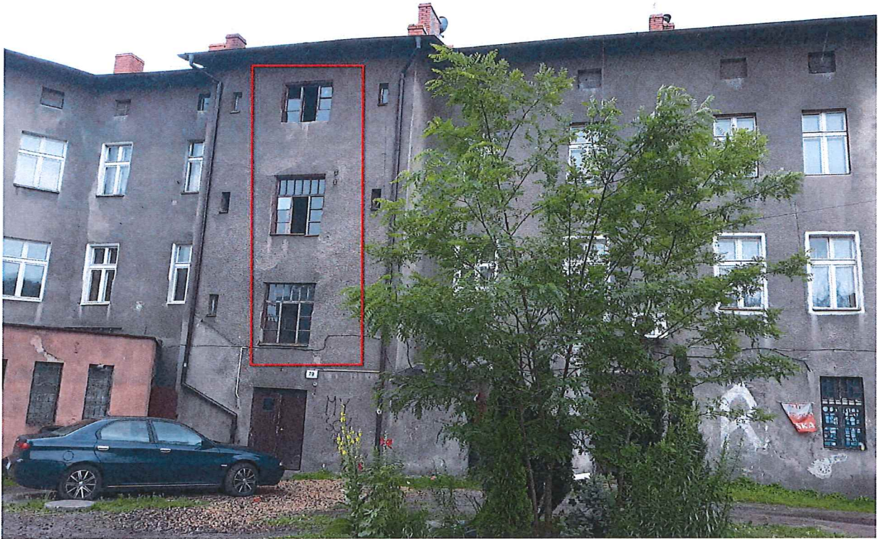
Fot. 4. Widok stolarki okiennej klatki schodowej do wymiany (elewacja od strony podwórza).
