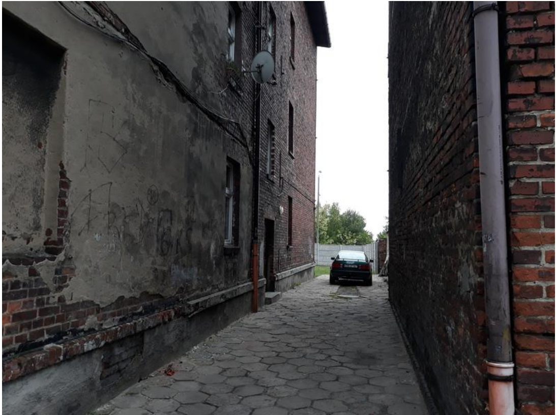
Fot. 3. Dojazd na podwórze.
