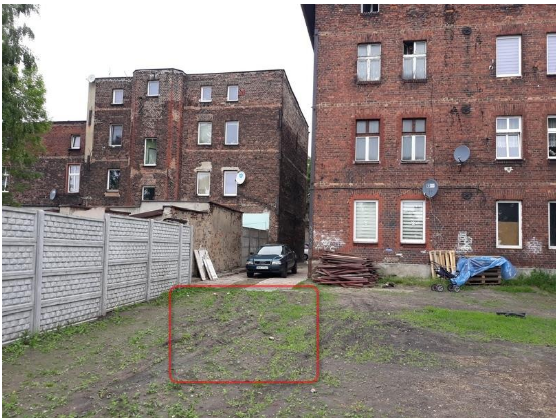
Fot. 8. Zbliżenie na sugerowaną lokalizację wiaty na odpady stałe.
