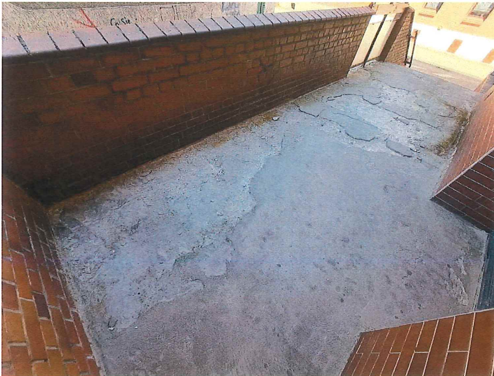
Fot. 9. Wylewka betonowa do skucia.
