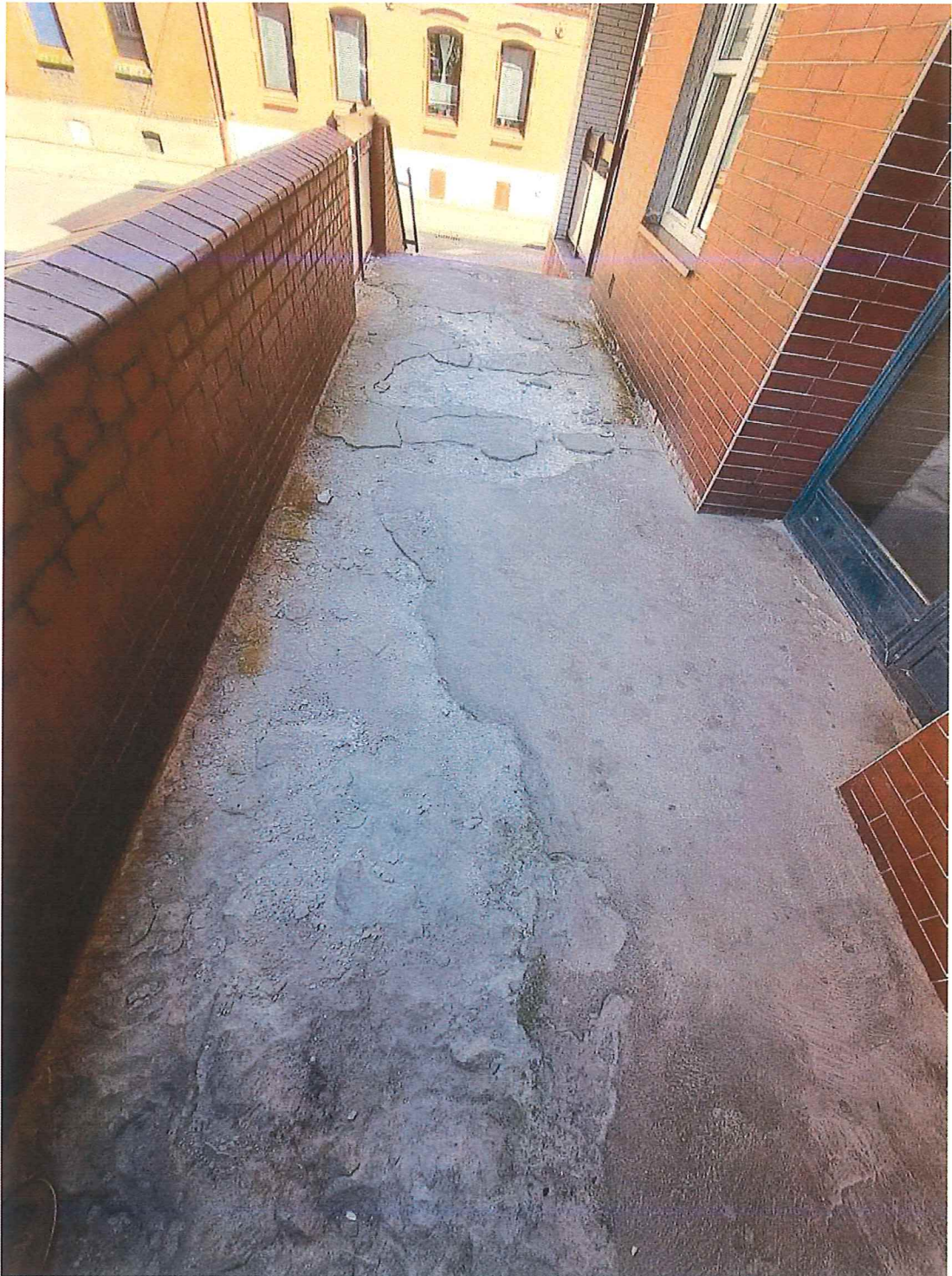
Fot. 10. Wylewka betonowa do skucia.
