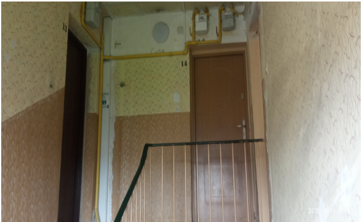
Fot. 4. Widok klatki schodowej.
