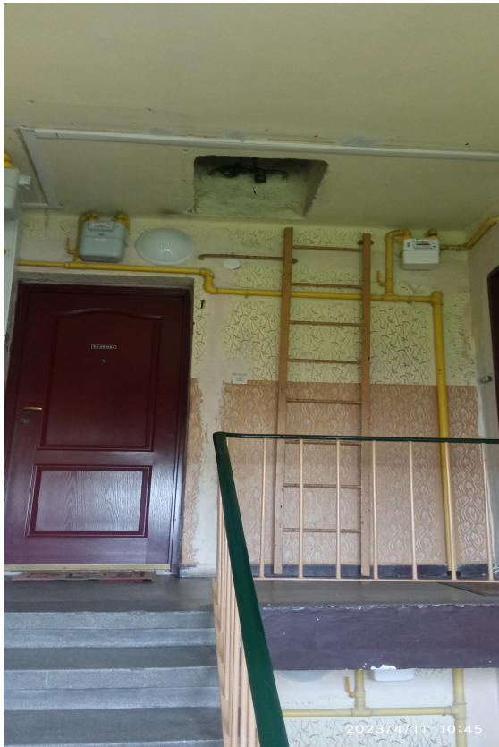
Fot. 2. Widok klatki schodowej (ostatnie piętro).
