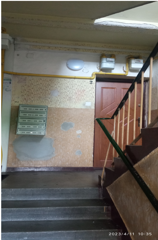
Fot. 3. Widok klatki schodowej
