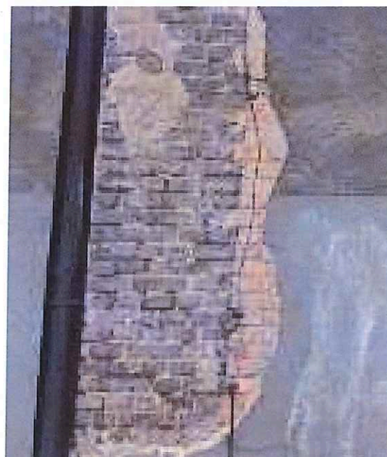
Fot. 5, 6. Ubytki tynku na elewacji. Widoczne замуrowania okien.
