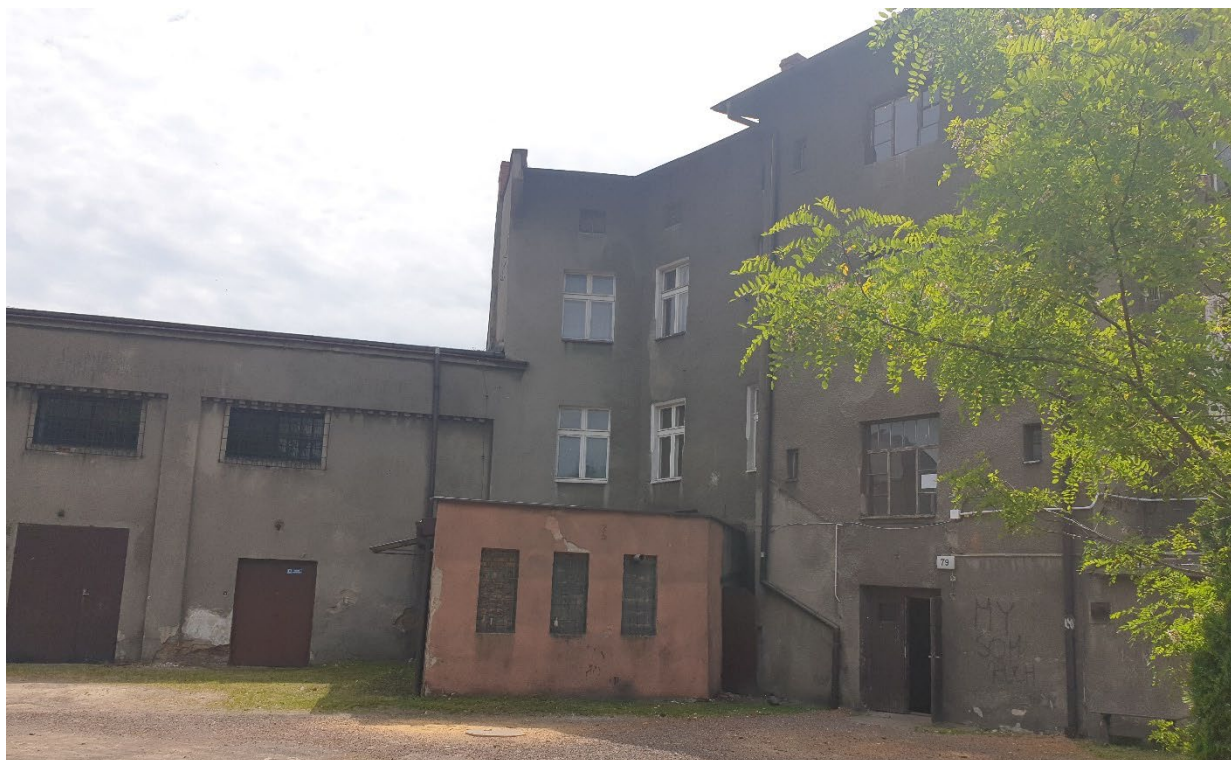
Fot.3 Elewacja tylna – północno-zachodnia
