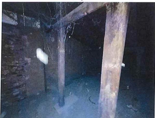
Fot. 58, 59. Zawilgocenie i zagrzybienie elementów więźby dachowej
