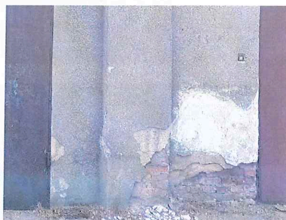
Fot. 8, 9. Ubytki tynku na elewacji.
