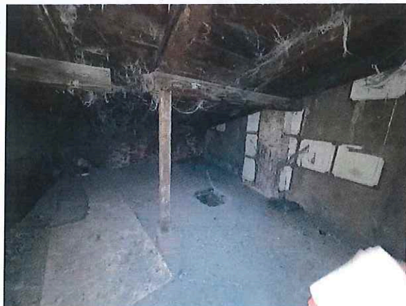
Fot.52, 53. Strych – widok ogólny. Widoczne znaczne zanieczyszczenia belek stropowych i płyt sufitowych
