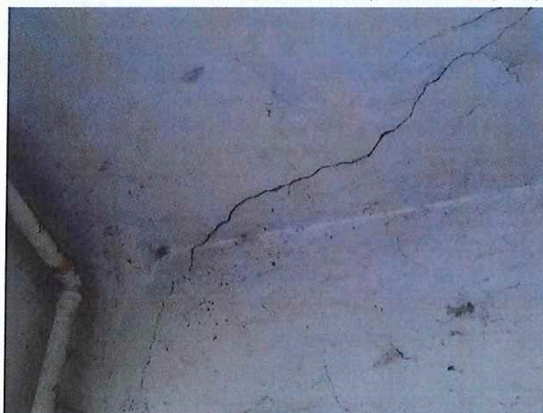
Fot. 42, 43. Uszkodzenia stropu antresoli
