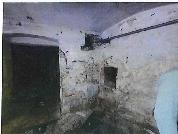
Fot. 22, 23. Ubytki fragmentów muru
