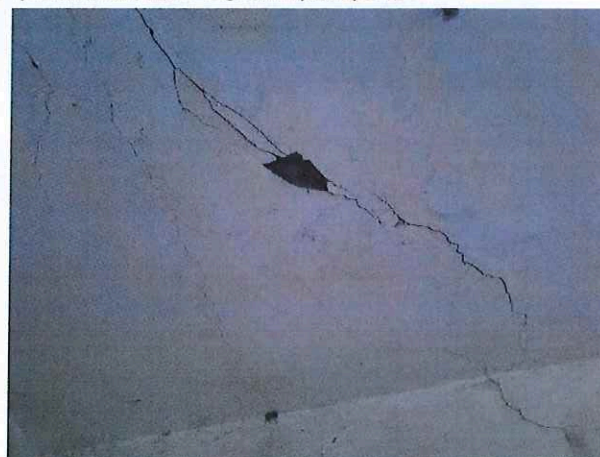
Fot. 42, 43. Uszkodzenia stropu antresoli
