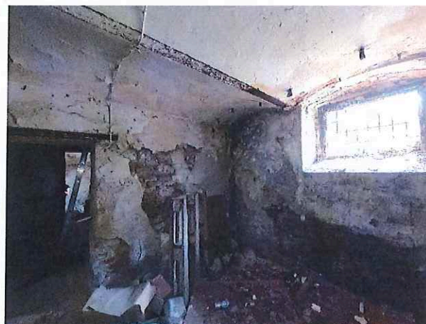
Fot. 20, 21. Widok ogólny piwnicy. Luźne tynki, zawilgocenie i zmurszenie cegieł znaczna korozja belek stalowych.
