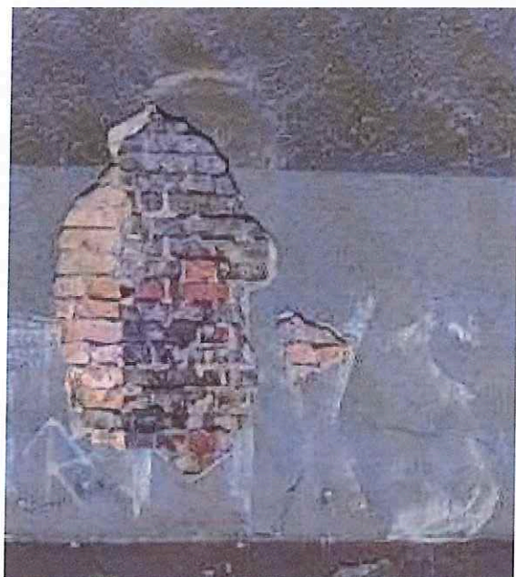
Fot. 5, 6. Ubytki tynku na elewacji. Widoczne замуrowania okien.
