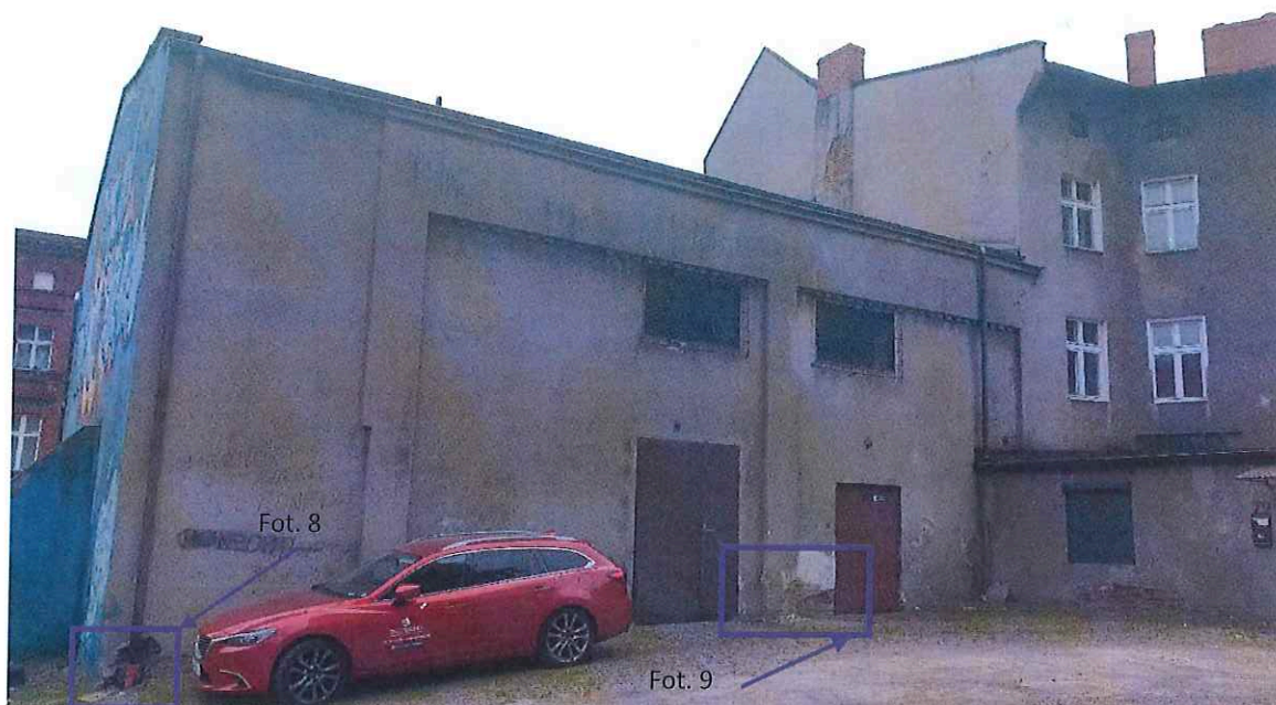
Fot. 7. Elewacja północno-zachodnia
