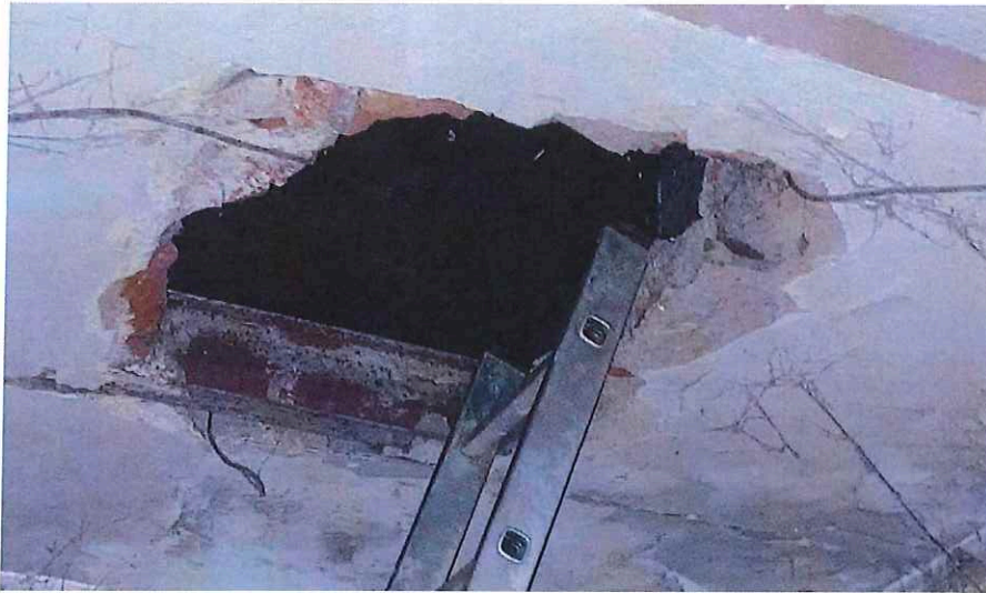
Fot. 64. Ogólny widok odkrywki stropu nad antresolą
