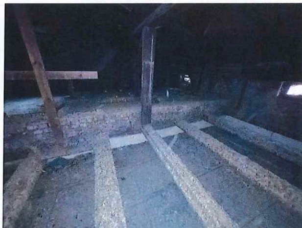
Fot.52, 53. Strych – widok ogólny. Widoczne znaczne zanieczyszczenia belek stropowych i płyt sufitowych
