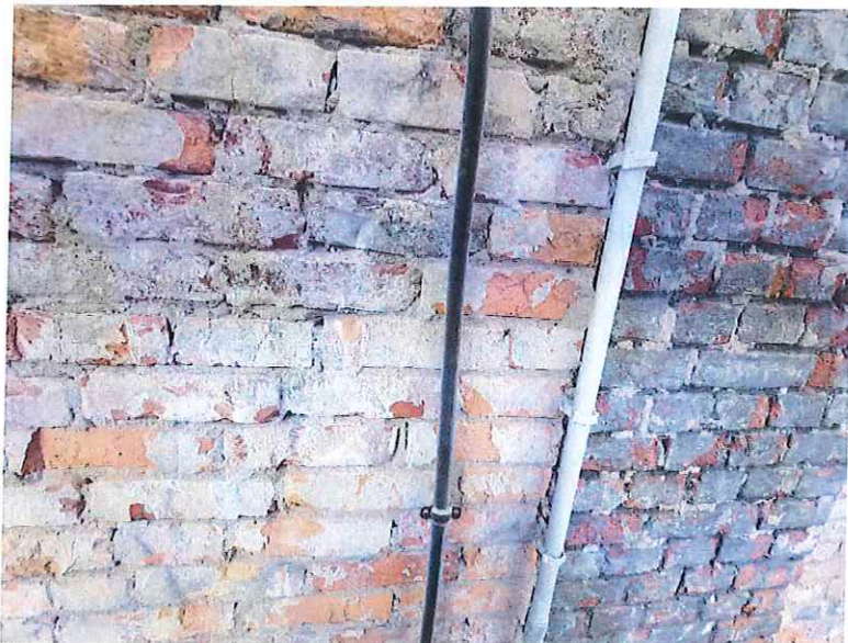
Fot. 67. Widoczne wtórne zamurowanie płyciny
