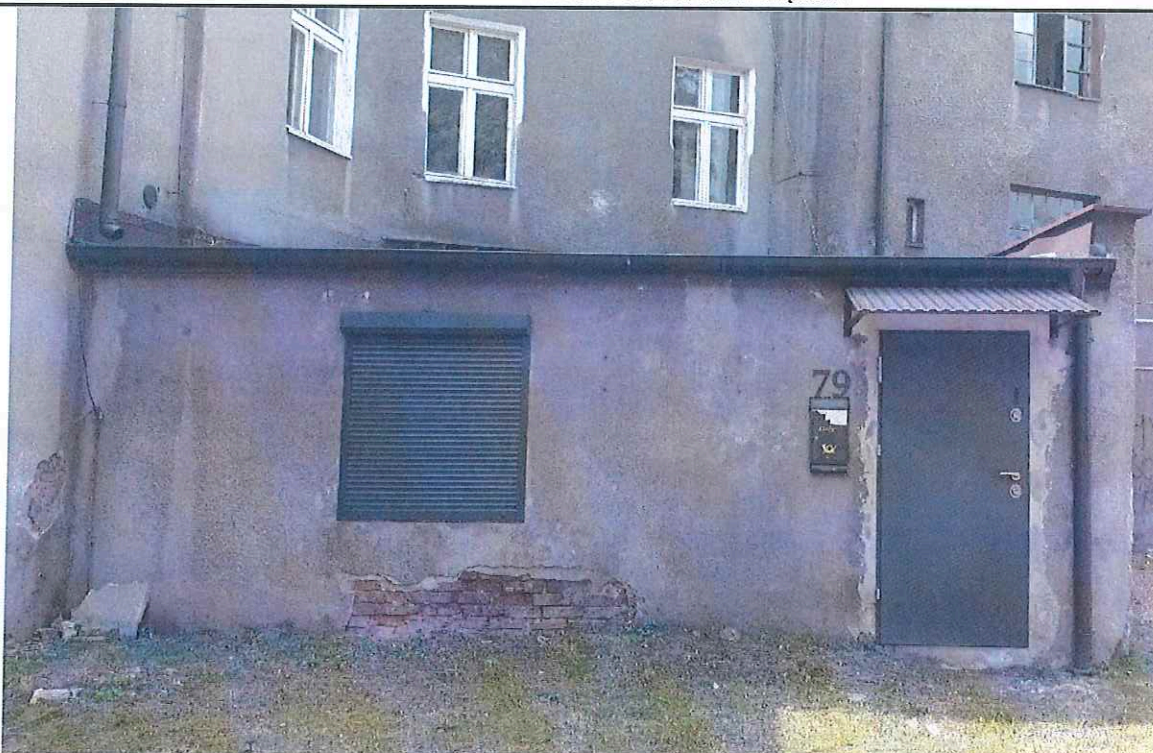
Fot. 13. Elewacja północno-wschodnia – wejście do przedmiotowej części budynku.
