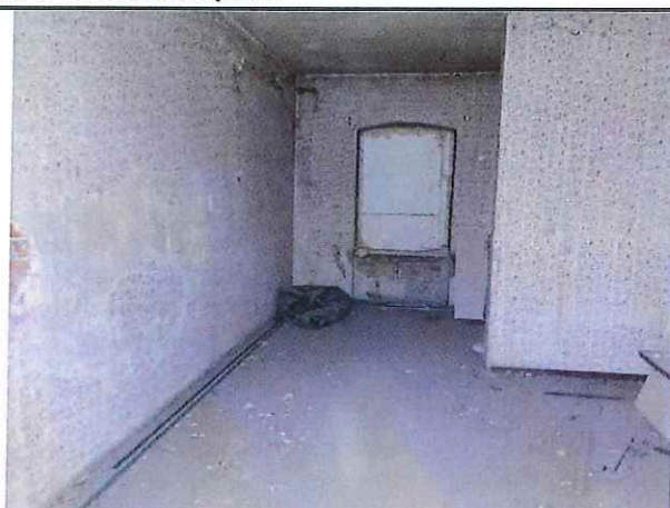
Fot.49. Zamurowane okno na antresoli (od strony elewacji frontowej)
