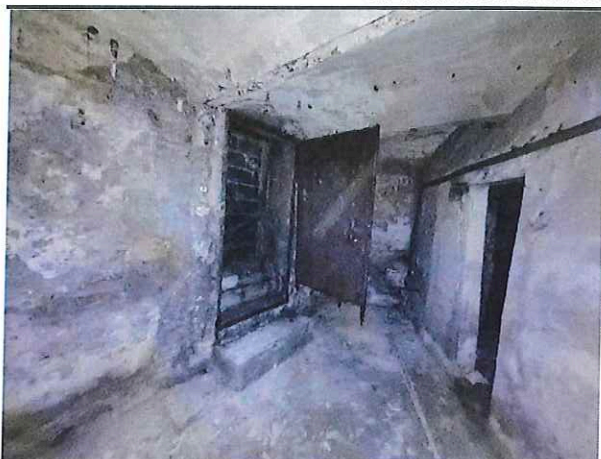
Fot. 24. Zamurowane zejście do piwnicy
