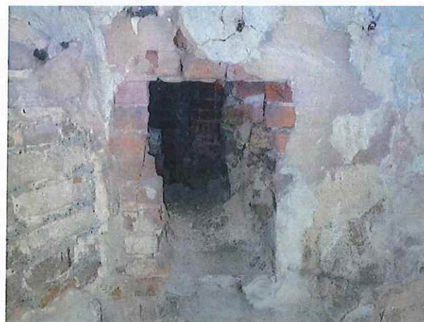
Fot. 22, 23. Ubytki fragmentów muru
