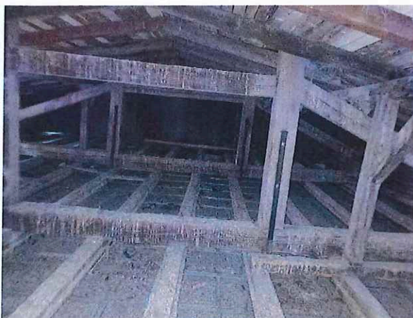
Fot.52, 53. Strych – widok ogólny. Widoczne znaczne zanieczyszczenia belek stropowych i płyt sufitowych
