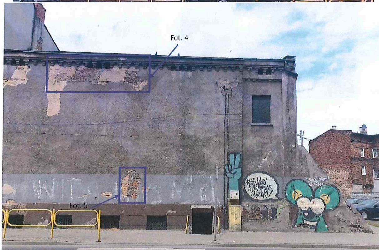
Fot. 2, 3. Elewacja frontowa południowo-wschodnia
