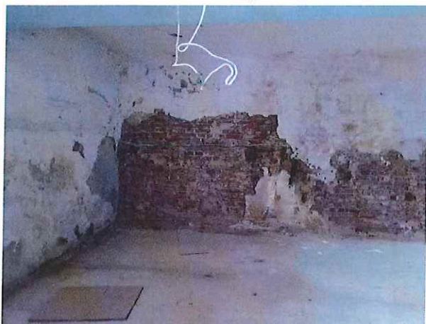
Fot. 40, 41. Ściana pod antresolą. Ubytki tynku, zmurszenie cegieł, ubytki spoin.
