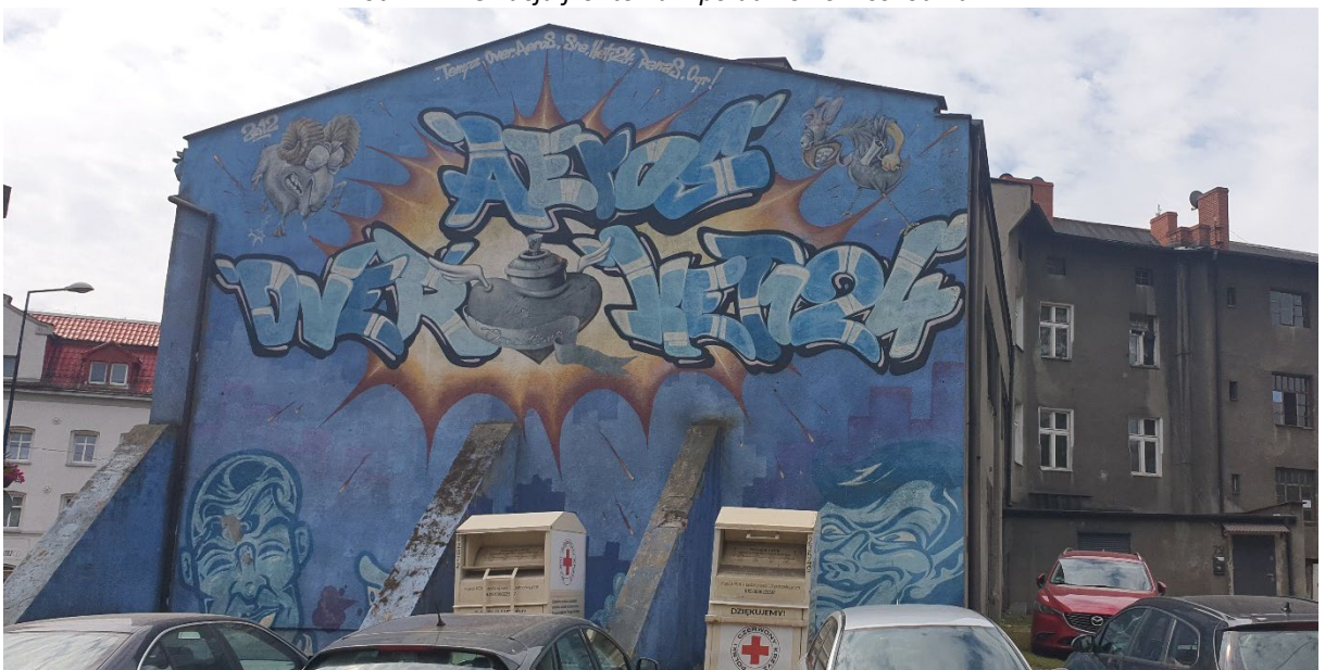
Fot.2 Elewacja boczna – północno-wschodnia
