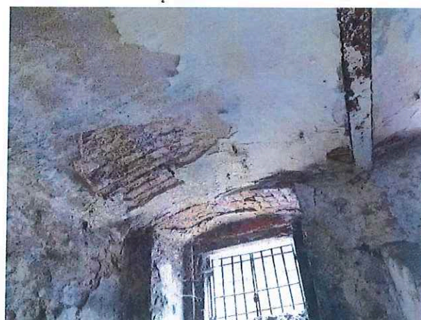
Fot. 26, 27. Skorodowane belki stalowe, ubytki tynku i spoin oraz zmurszenie cegieł stropu
