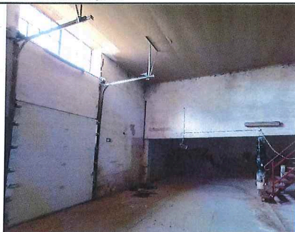
Fot. 39. Brama segmentowa
