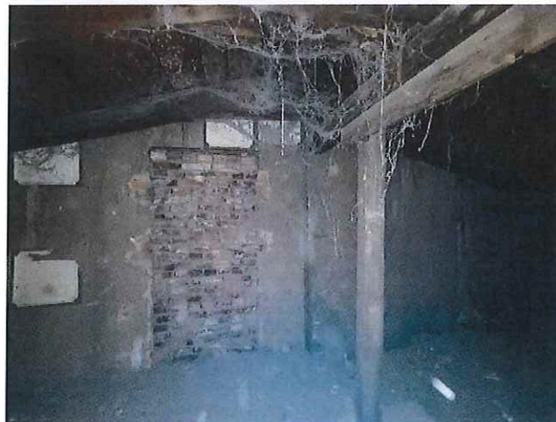
Fot. 55. Widok na zamurowany otwór drzwiowy.
