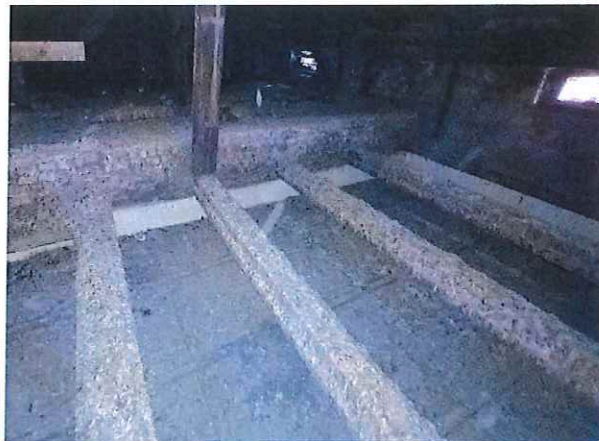
Fot. 66. Belki stropowe na strychu
