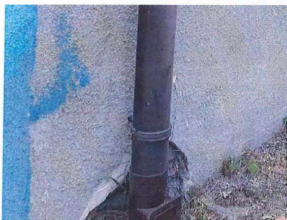
Fot. 8, 9. Ubytki tynku na elewacji.
