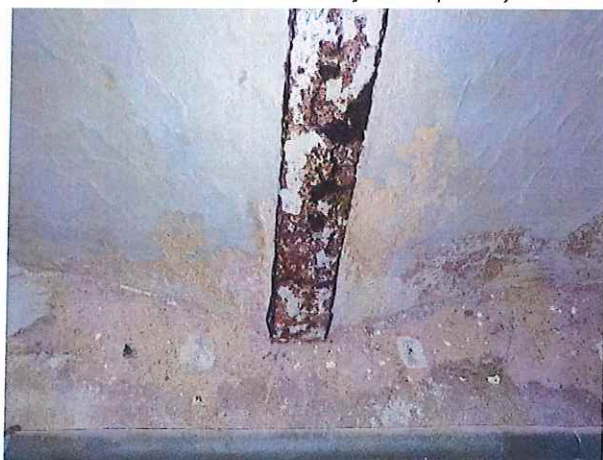
Fot. 26, 27. Skorodowane belki stalowe, ubytki tynku i spoin oraz zmurszenie cegieł stropu
