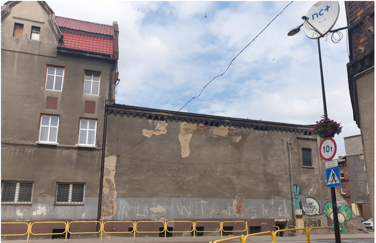
Fot. 1. Elewacja frontowa – południowo-wschodnia
