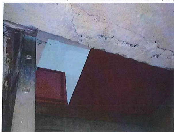
Fot. 28. Właz do piwnicy.
