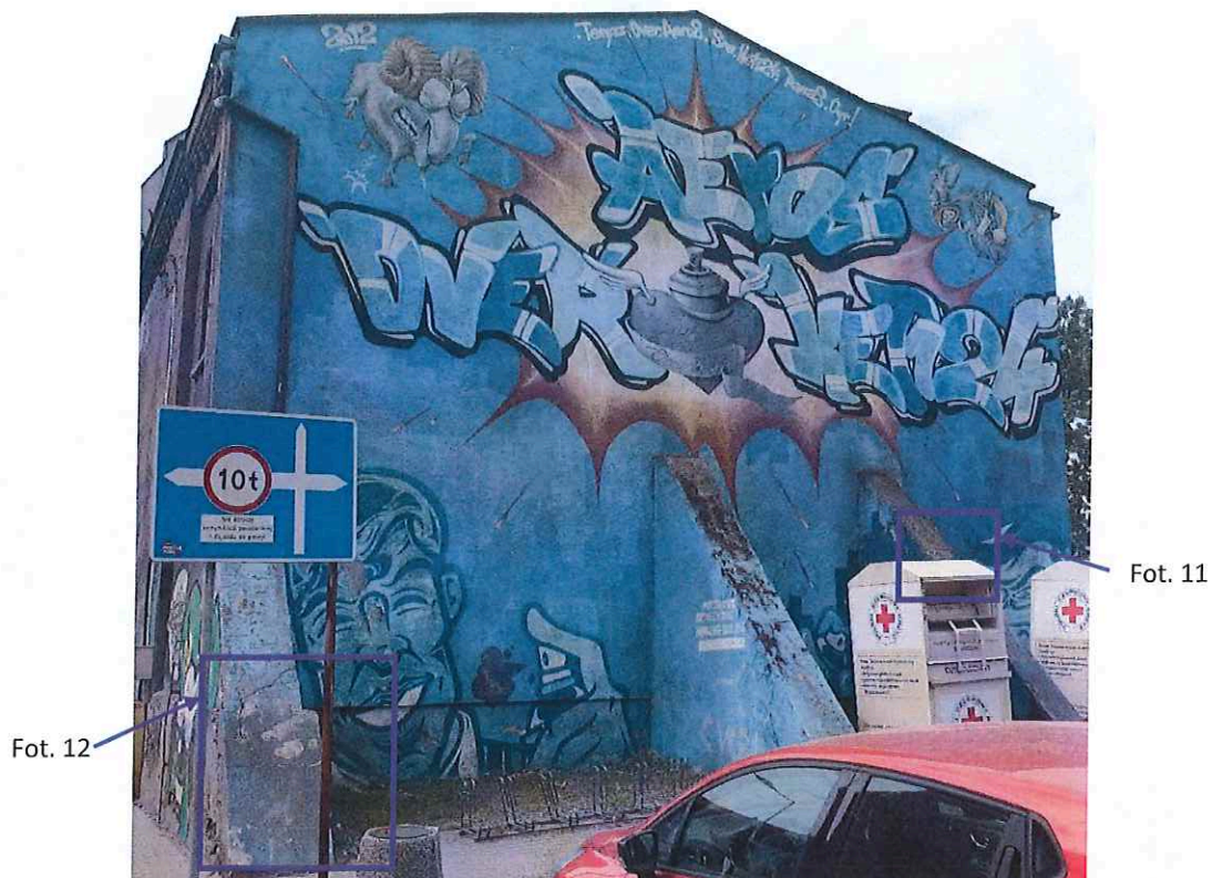
Fot. 10. Elewacja szczytowa.
