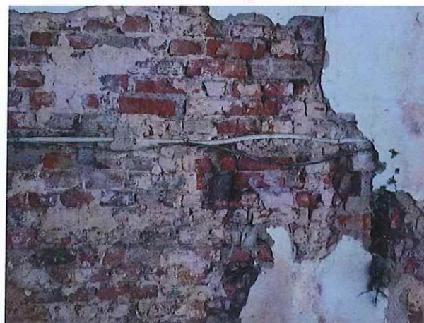
Fot. 40, 41. Ściana pod antresolą. Ubytki tynku, zmurszenie cegieł, ubytki spoin.
