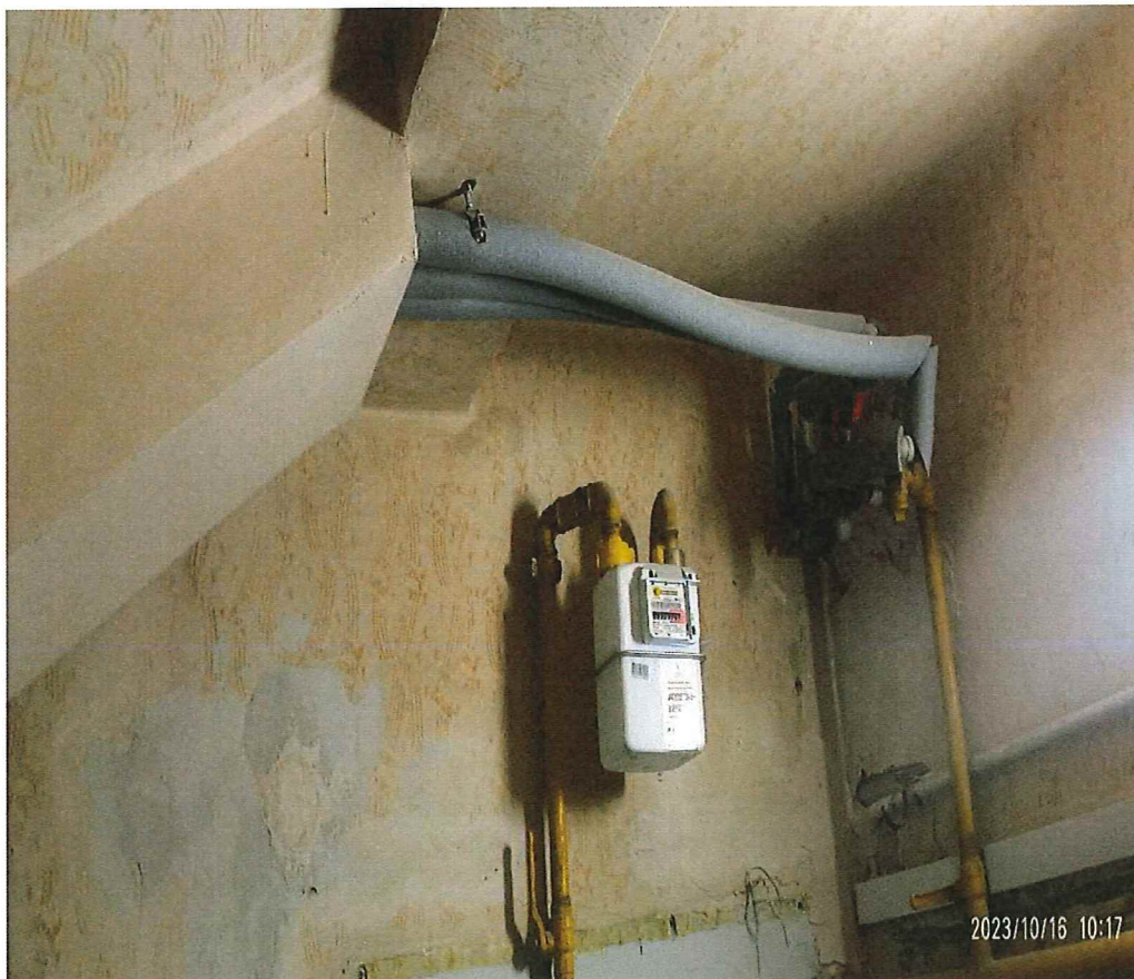
Fot. 4. Widok klatki schodowej (zabudowy do wykonania)
