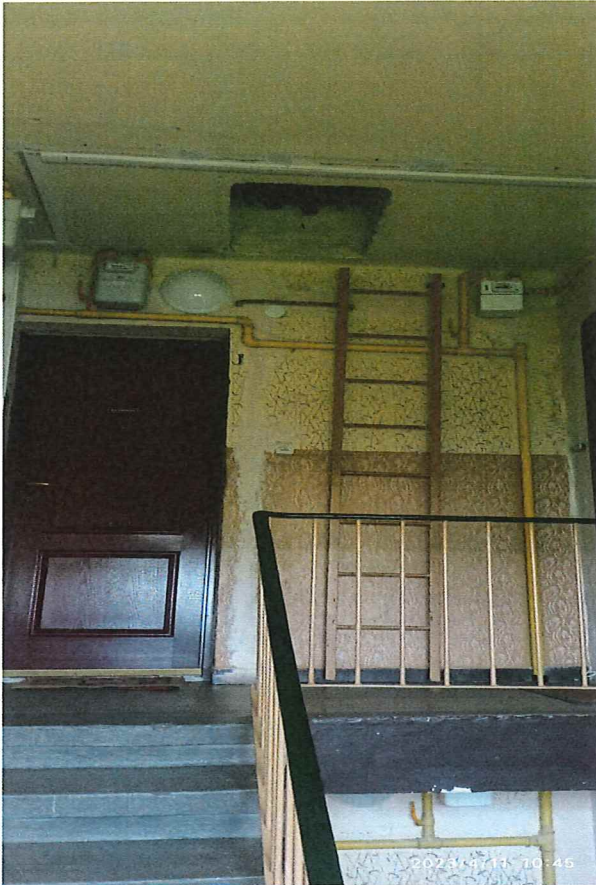
Fot. 2. Widok klatki schodowej (ostatnie piętro).
