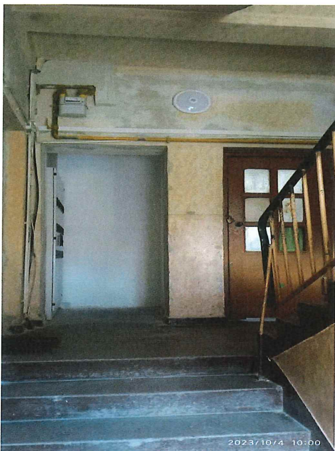
Fot. 5. Widok klatki schodowej (parter)
