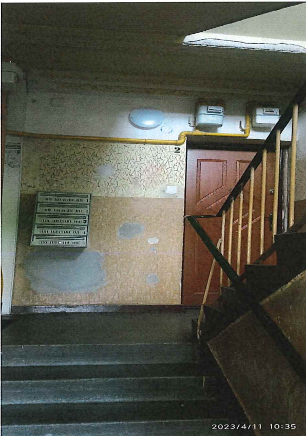
Fot. 3. Widok klatki schodowej
