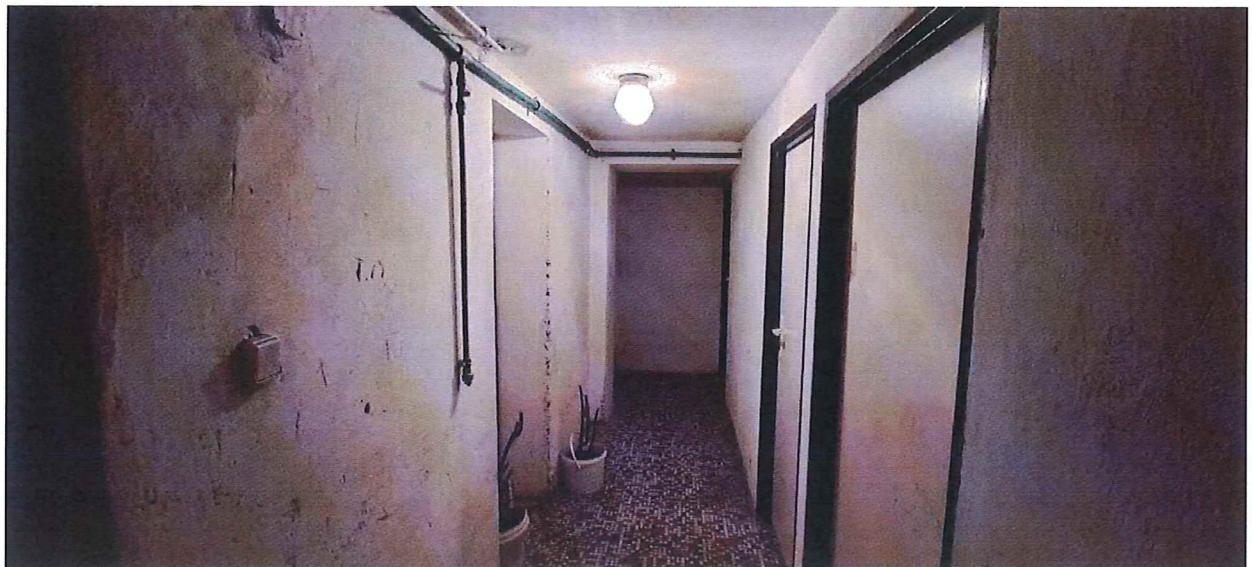
Fot. 11. Widok korytarza w piwnicy prowadzącego do komórek lokatorskich.
