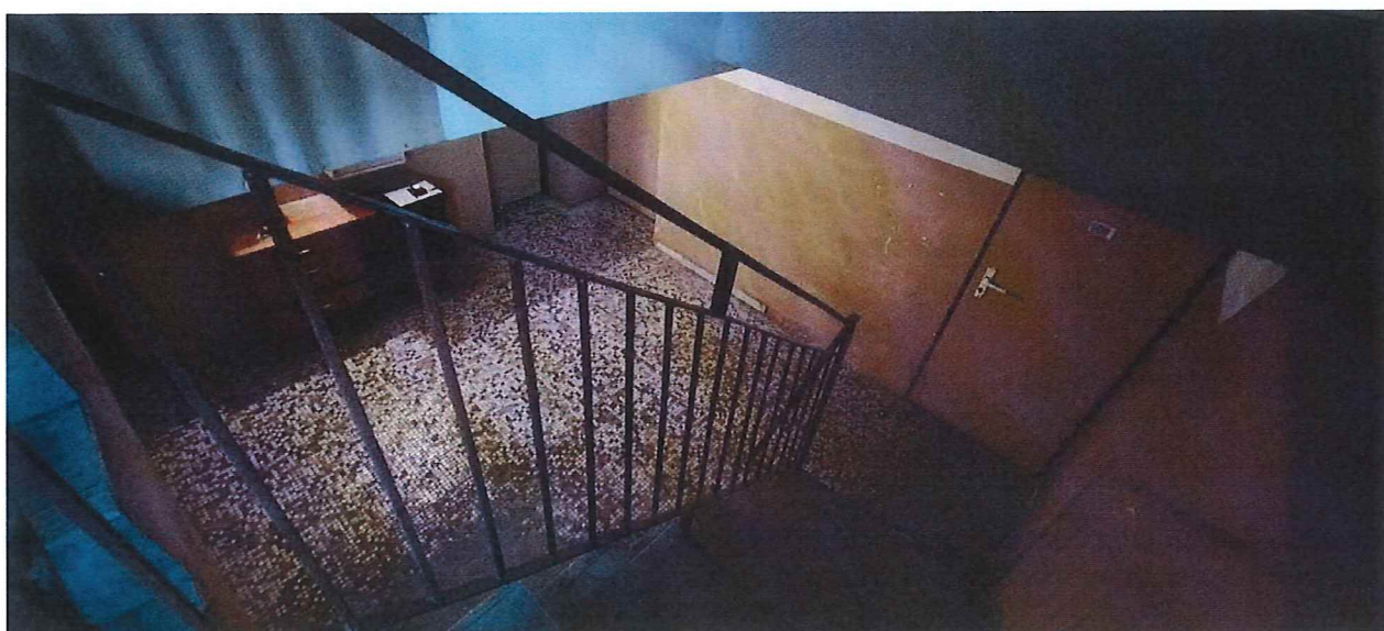
Fot. 5. Zejście do części wspólnych w piwnicy.
