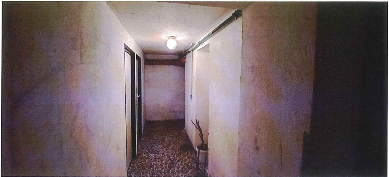
Fot. 10. Widok korytarza w piwnicy prowadzącego do komórek lokatorskich.
