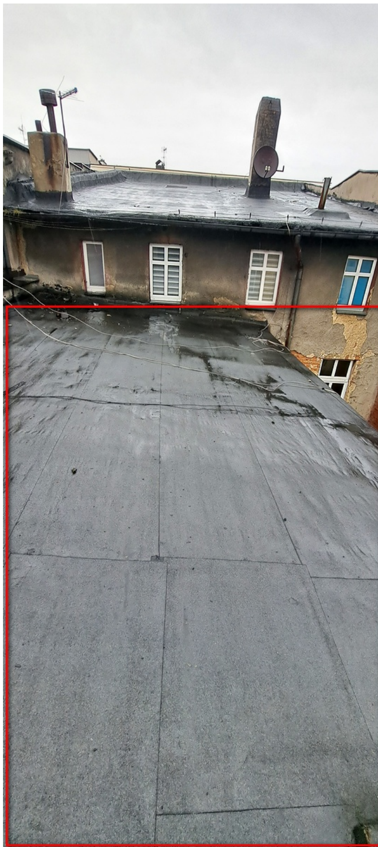
Fot. 12. Widok ogólny połaci dachowej do remontu.
