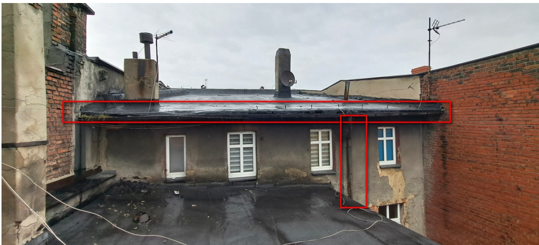
Fot. 10. Widok orywnowania części wyższej do wymiany na nowe (w drugim kierunku).
