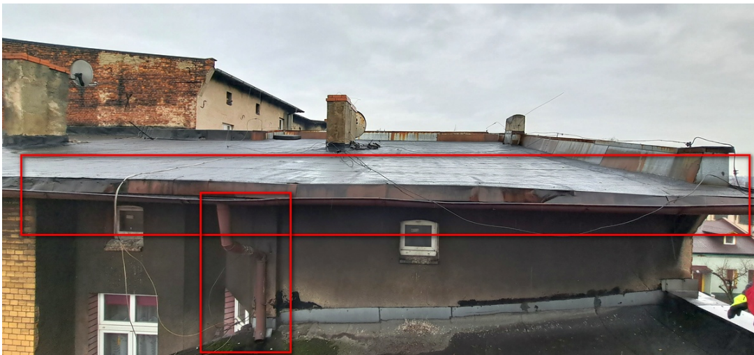
Fot. 9. Widok orywnowania części wyższej do wymiany na nowe.
