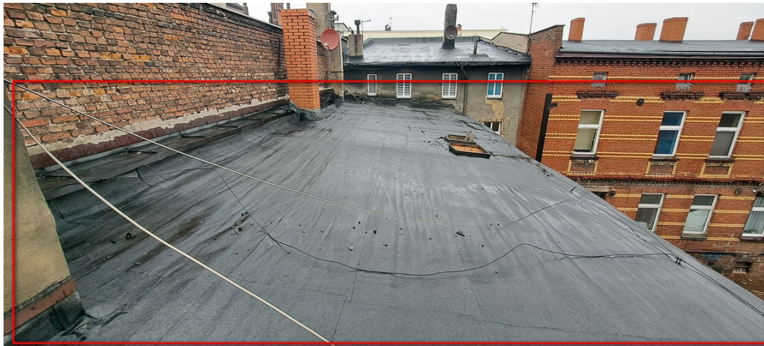
Fot. 3. Widok ogólny połąci dachowej do remontu.
