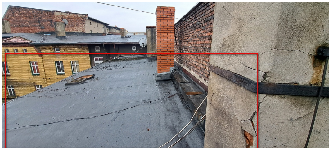
Fot. 4. Widok ogólny połąci dachowej do remontu w drugim kierunku.
