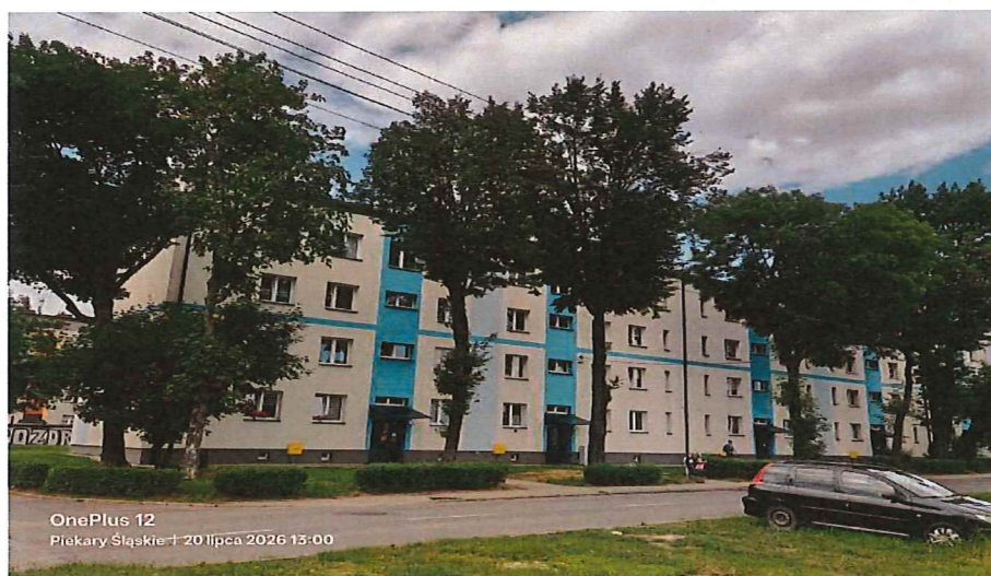
Foto. 1 - Widok ogólny budynku
