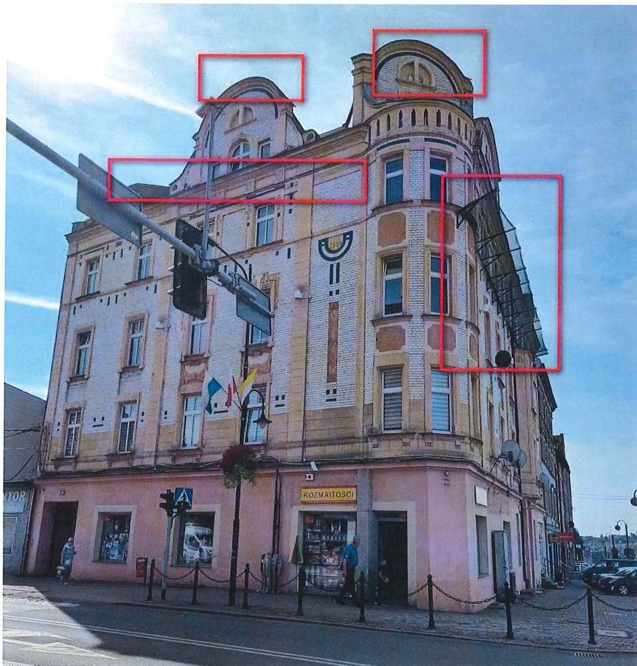
Fot. 3. Widok naroża budynku od strony skrzyżowania ul. Wyszyńskiego i Bytomskiej.
