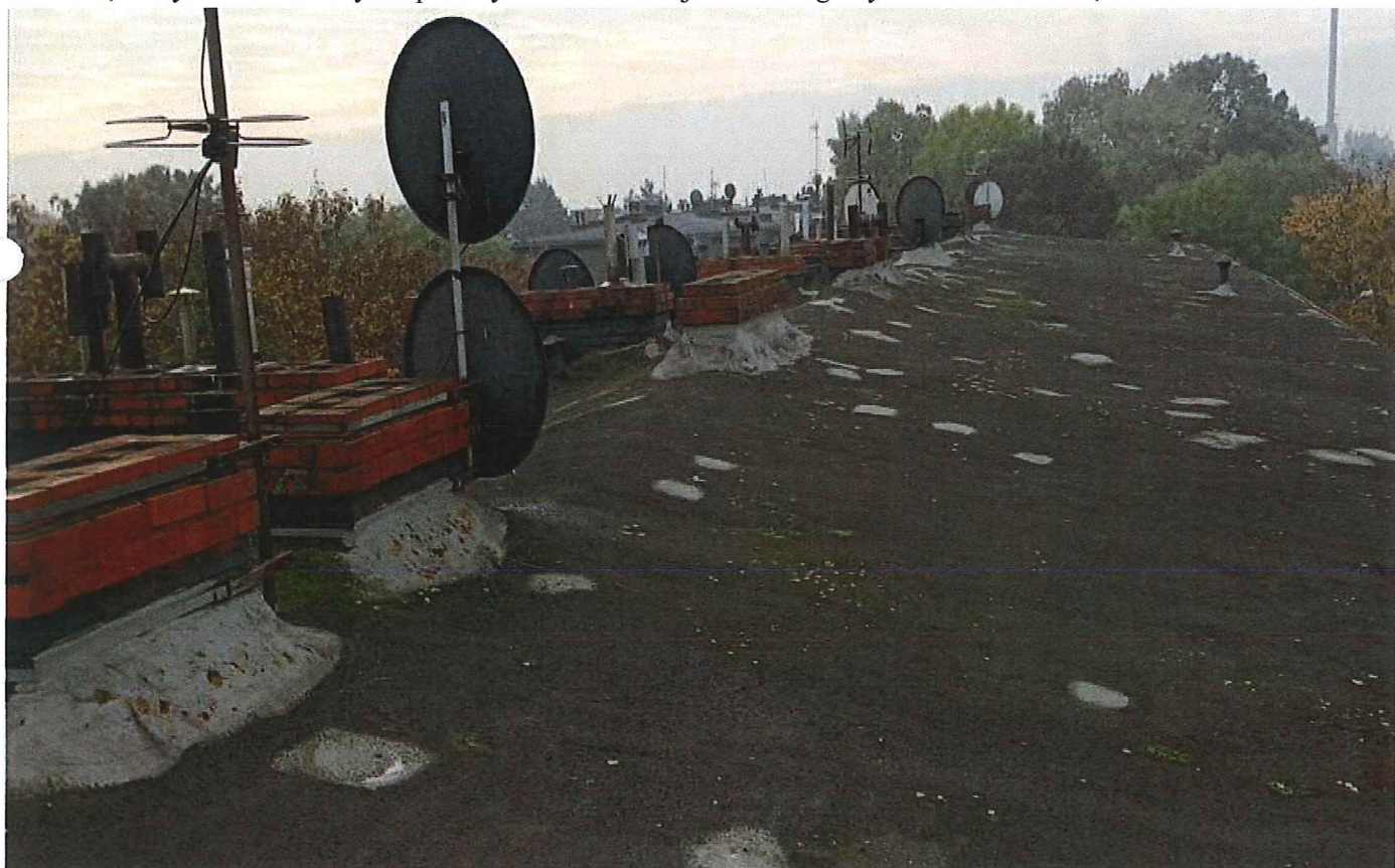
Załącznik nr 3; Budynek mieszkalny Wspólnoty Mieszkaniowej – widok ogólny dachu i kominów;
