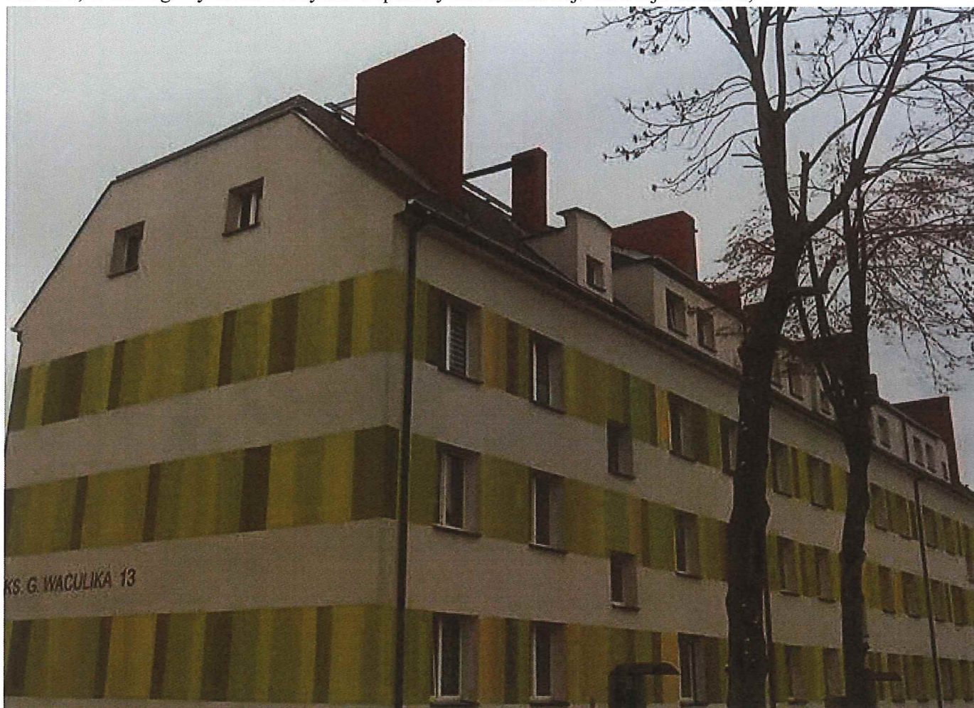
Zał. nr 2; Widok ogólny dachu i budynku Wspólnoty Mieszkaniowej - elewacja frontowa;
