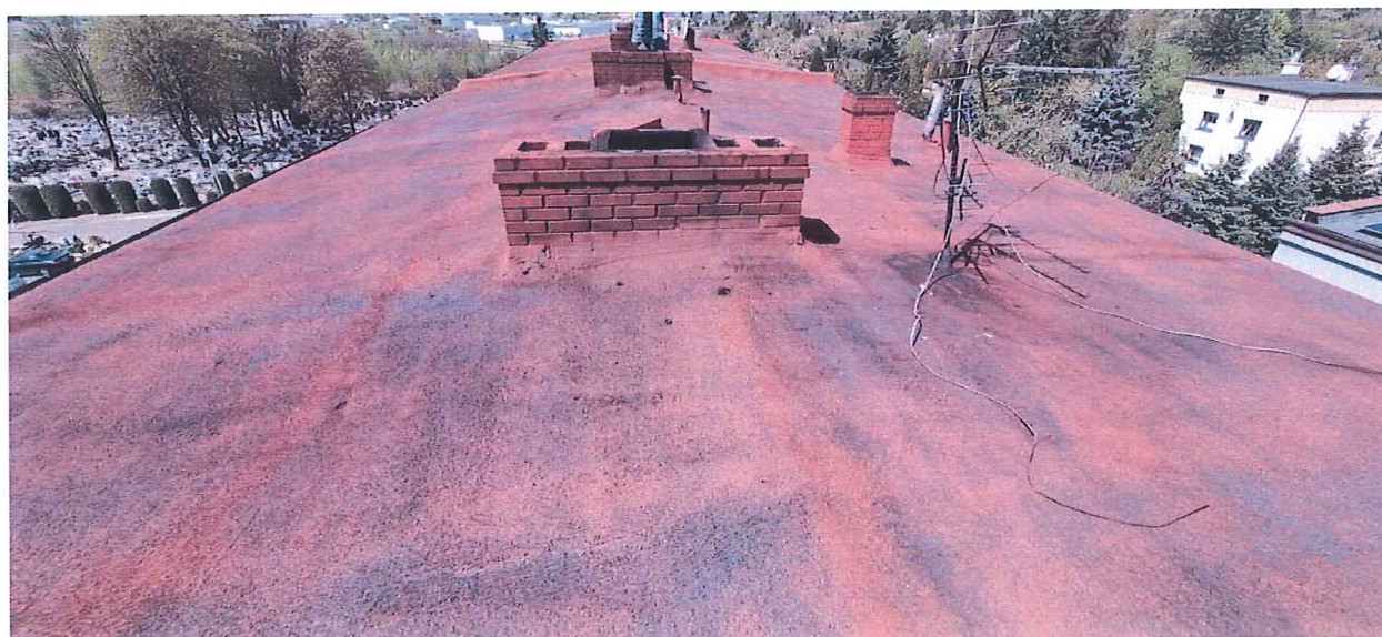
Fot. 7. Widok ogólnej połaci dachowej w drugim kierunku.
