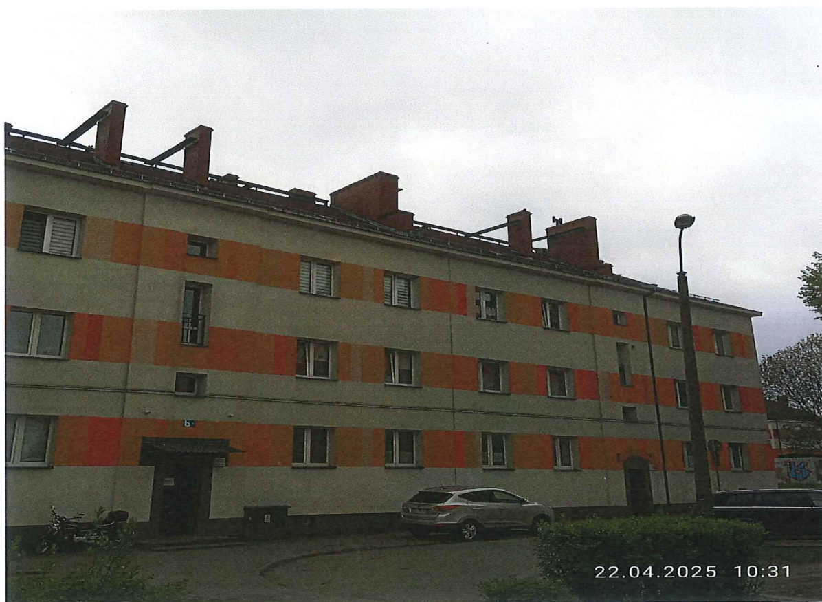
3,3a / Widok ogólny budynku, połaci dachu oraz istniejących drewnianych ław kominiarskich.
