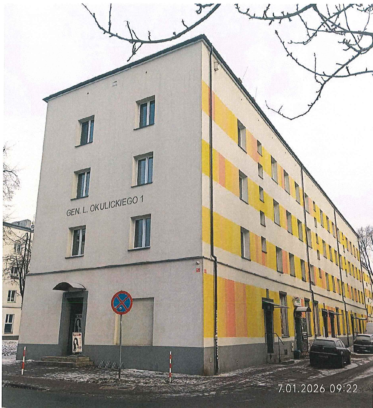
Fot. 1. Widok elewacji frontowej i tylnej budynku przy ul. Gen. Leopolda Okulickiego 1;
