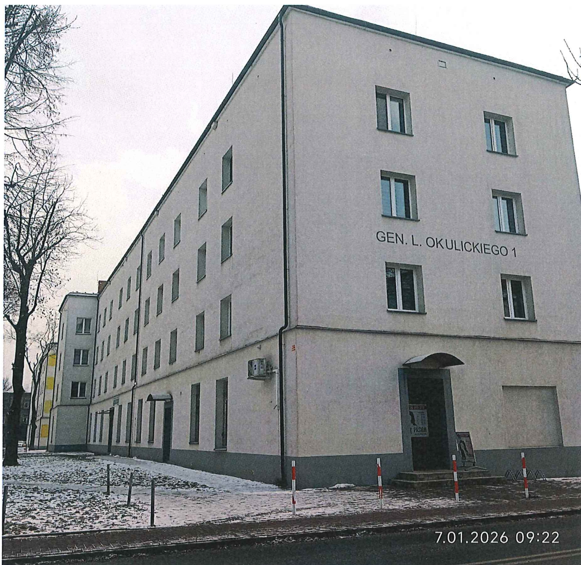
Fot. 2. Widok dojścia i lokalu przy ul. Gen. Leopolda Okulickiego 1;
