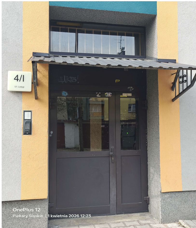
Foto. 1 – kl. schodowa Nr I
