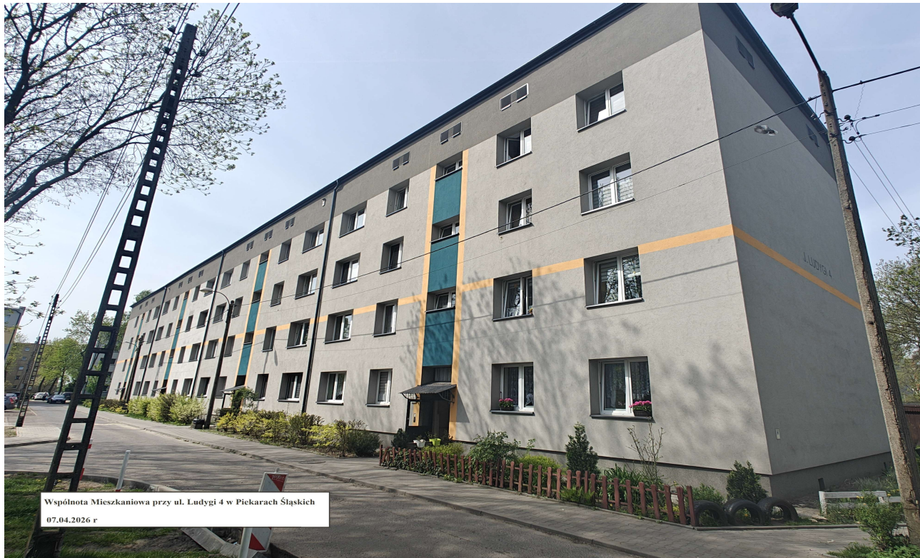
Foto. 1, 2, 3, 4 Widok ogólny istniejących drzwi wejściowych
