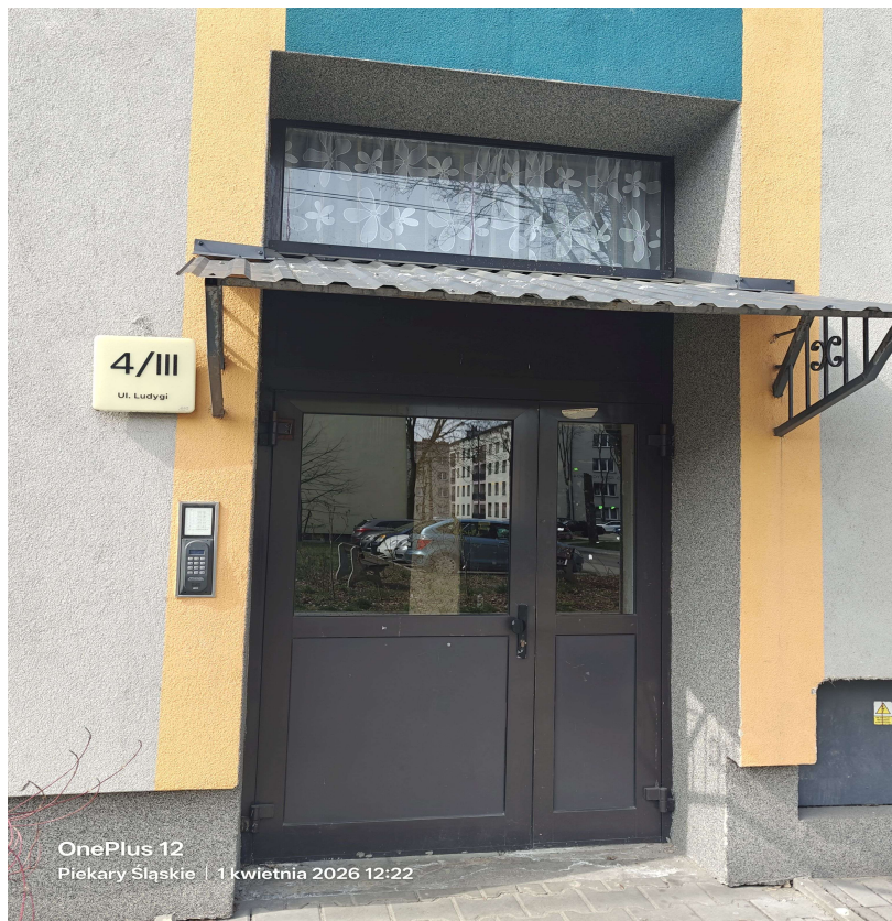
Foto. 3 – kl. schodowa Nr III
