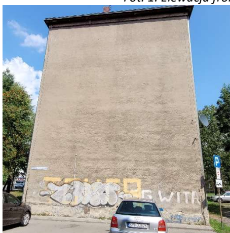
Fot. 2. Elewacja południowo-zachodnia
