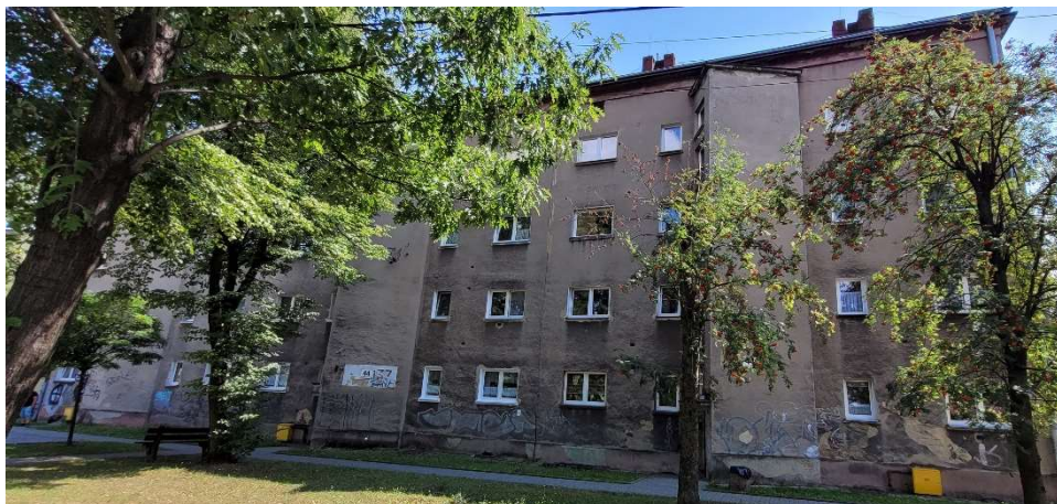
Fot. 1. Elewacja frontowa – północno-zachodnia
