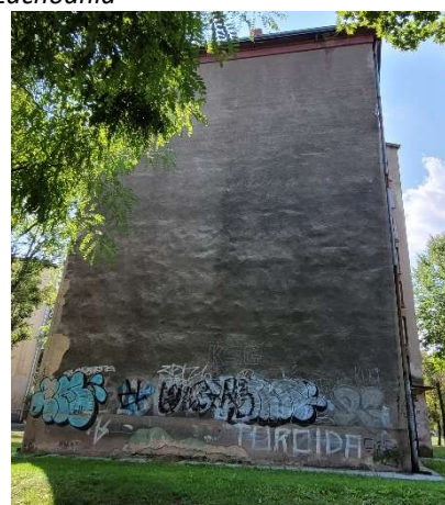
Fot. 3. Elewacja północno-wschodnia
