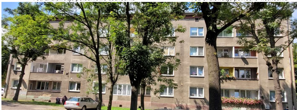
Fot. 4. Elewacja południowo-wschodnia
