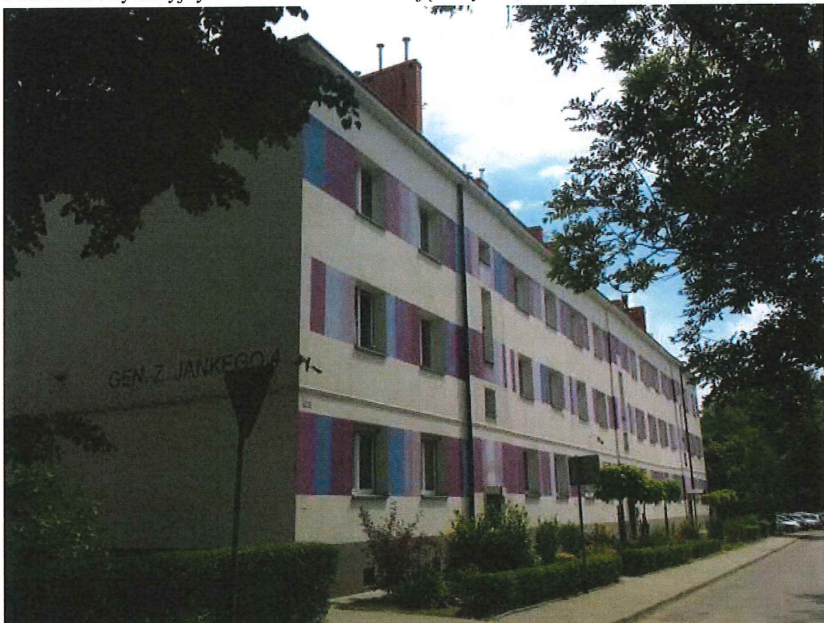
Fot. 2,3 Widok ogólny budynku wraz z miejscem wykonania odwodnienia;
