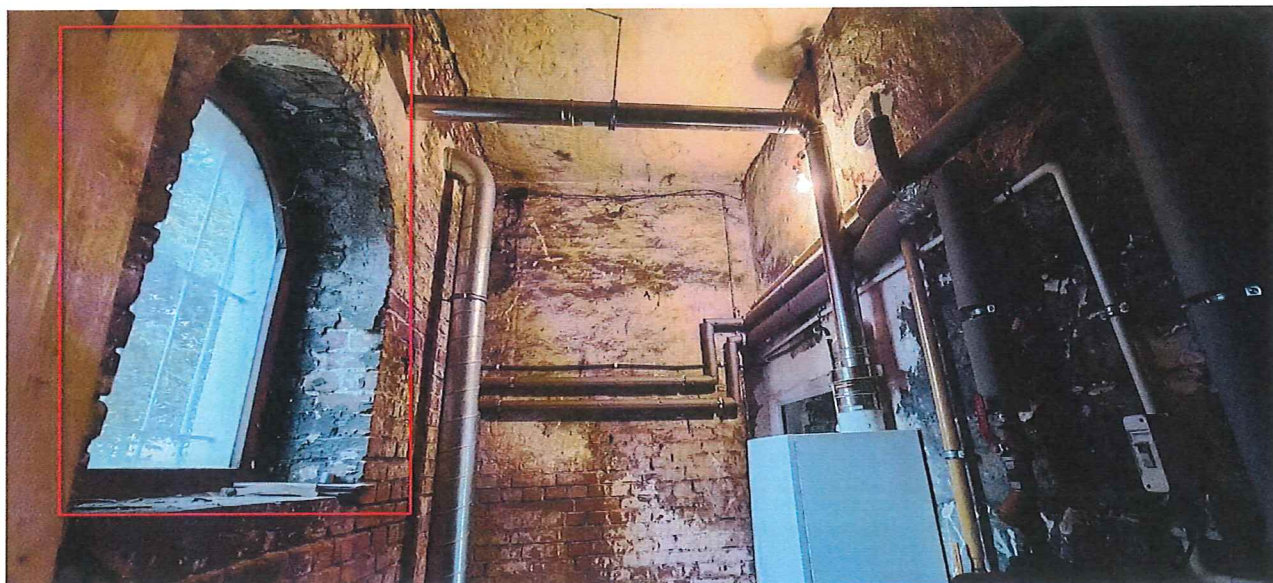
Fot. 6. Widok fragmentu kotłowni – okno do wymiany – kratka zewnętrzna pozostaje.
