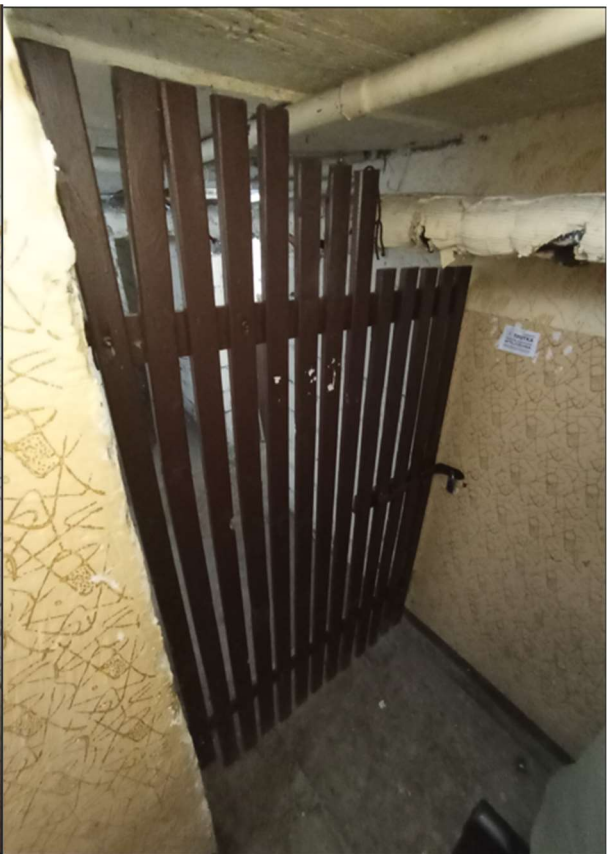
Klatka schodowa Nr 2
