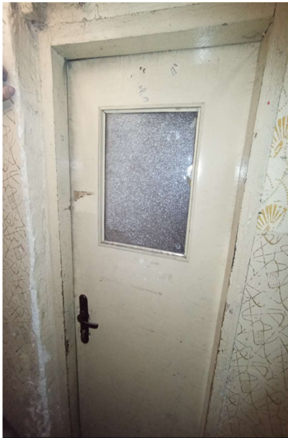
Wejście do piwnicy: klatka schodowa Nr 1
