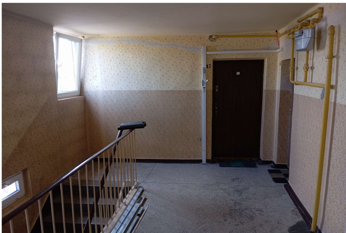
Fot. 2. Widok klatki schodowej (ostatnie piętro).
