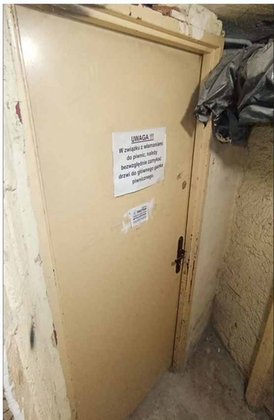
Wejście do piwnic: klatka schodowa Nr 3
