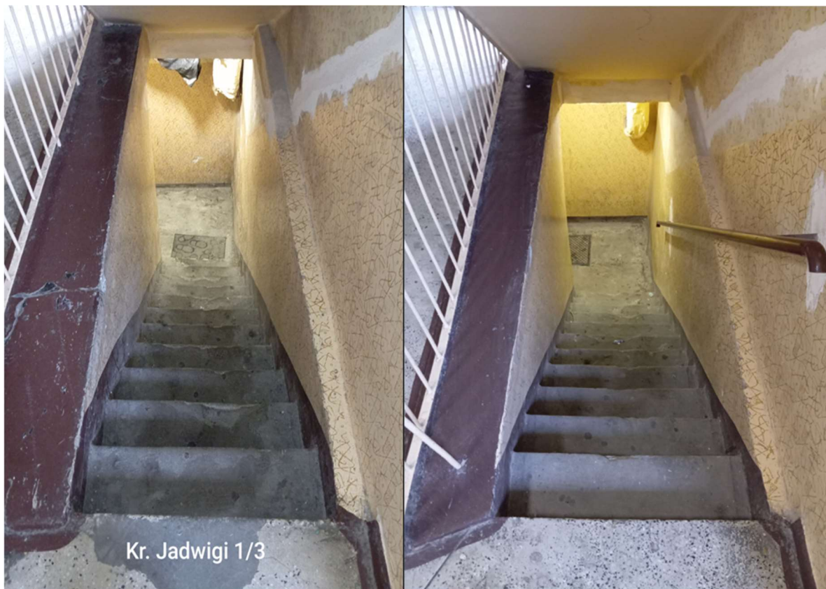
Zejsć do piwnic: klatka schodowa Nr 3
