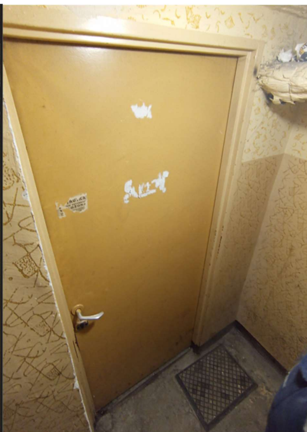
Klatka schodowa Nr 4
