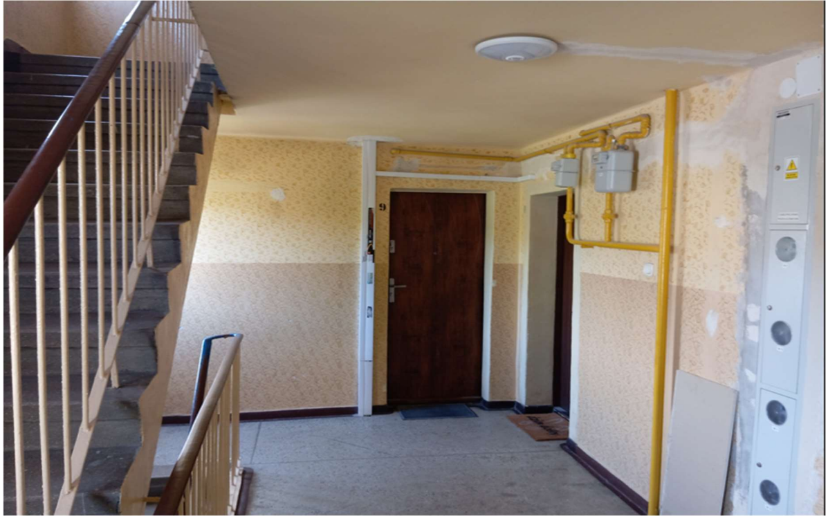
Fot. 3. Widok klatki schodowej
