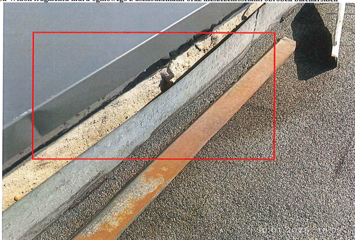
Fot. 5a Widok fragmentu muru ogniowego z uszkodzeniami oraz nieszczelnościami obróbek blacharskich
